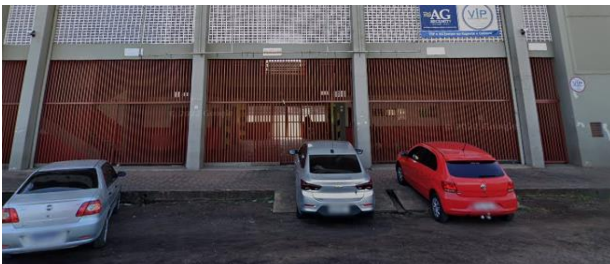
Foto 4 (Portão Oeste - Principal, acesso a arquibancada norte)
