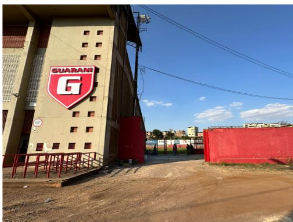
Foto 7 (Portão de Serviço Oeste)
