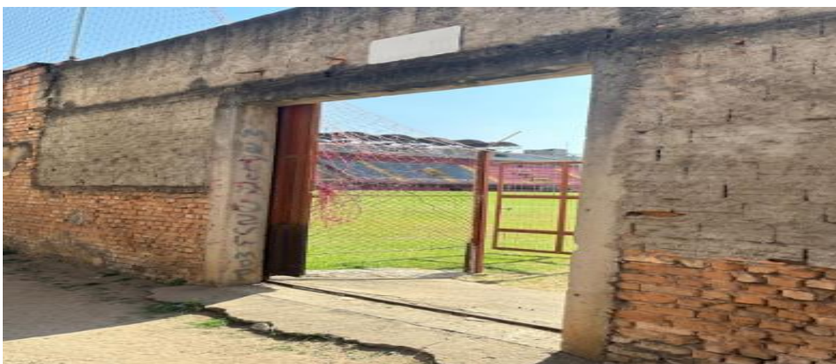
Foto 3 (Portão Sul - Setor Visitante, acesso a arquibancada leste)
