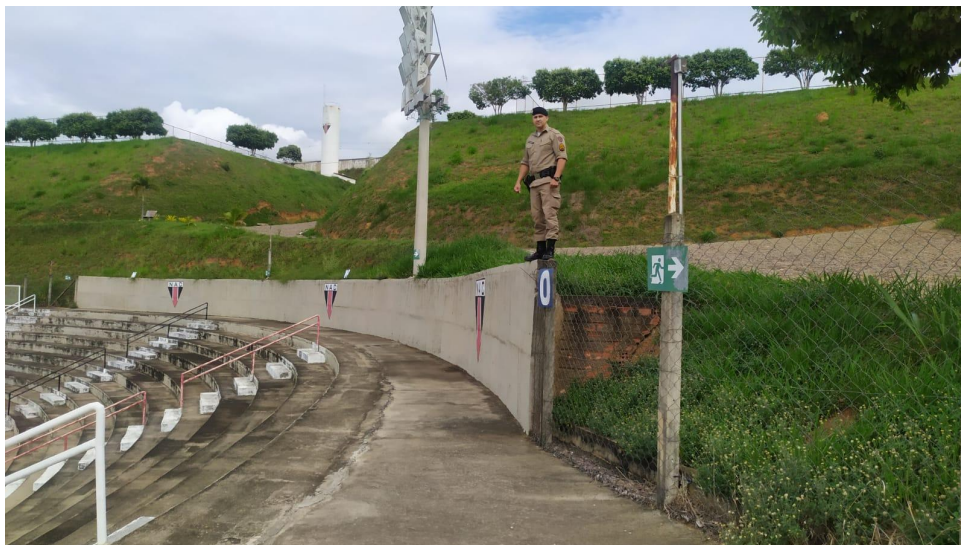
Fotografia 14 - Alambrados e muretas do entorno do estacionamento
