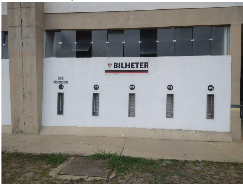
Fotografia 27 - Bilheteria do estádio
