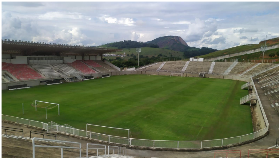
Fotografia 22 - Grades de proteção no entorno de toda a arquibancada
