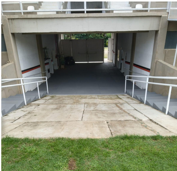
Fotografia 28 - Rampa de acesso da ambulância ao campo
