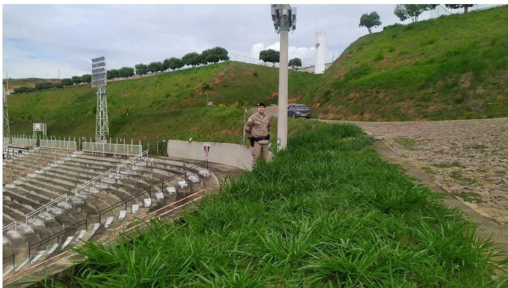
Fotografia 15 - Alambrados e muretas do entorno do estacionamento
