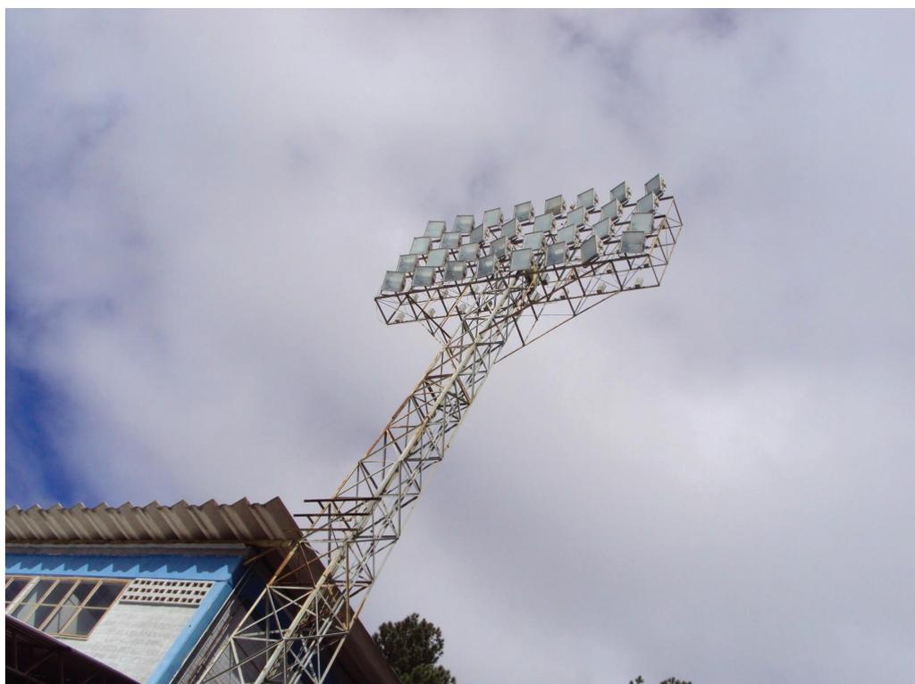
Foto 25 - Detalhe torre de iluminação (T1) – 32 refletores de 2.000W estádio possui 04 destas perfazendo um total de 256 kW de iluminação
