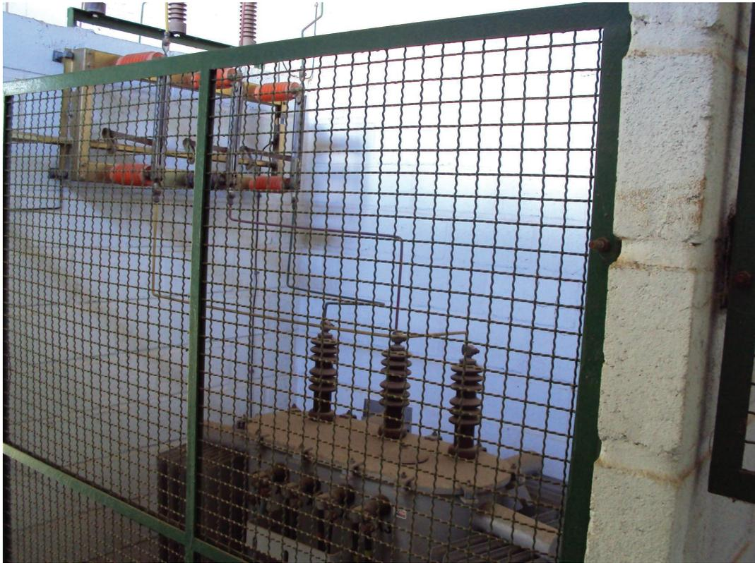
Foto 19 - Primeira subestação – Transformador 225 kVA/ 380V.
