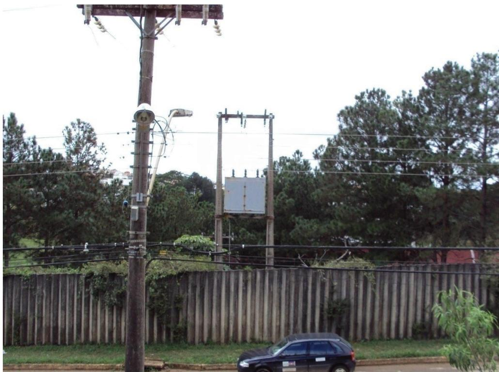
Foto 16 - Detalhe da tomada de energia - ponto de entrega da CEMIG – 23kV
