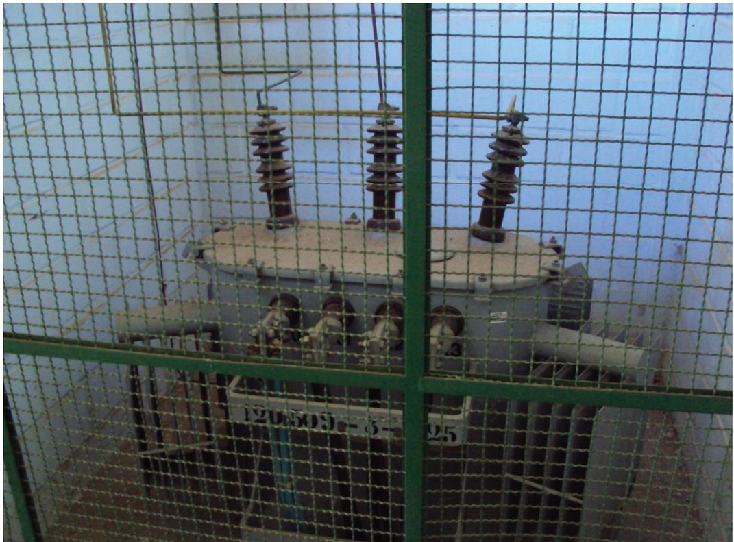
Foto 29- Segunda subestação – Transformador 225kVA / 220V
