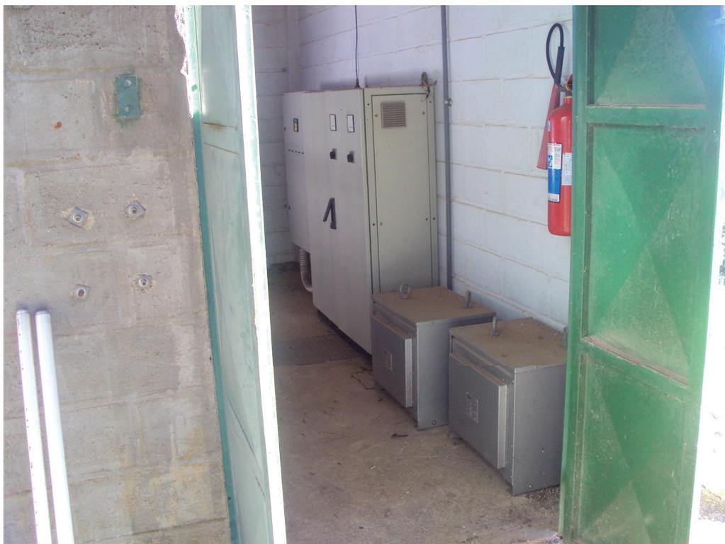
Foto 21- Primeira subestação transformadores 380V / 220V – Quadros comando e proteção
