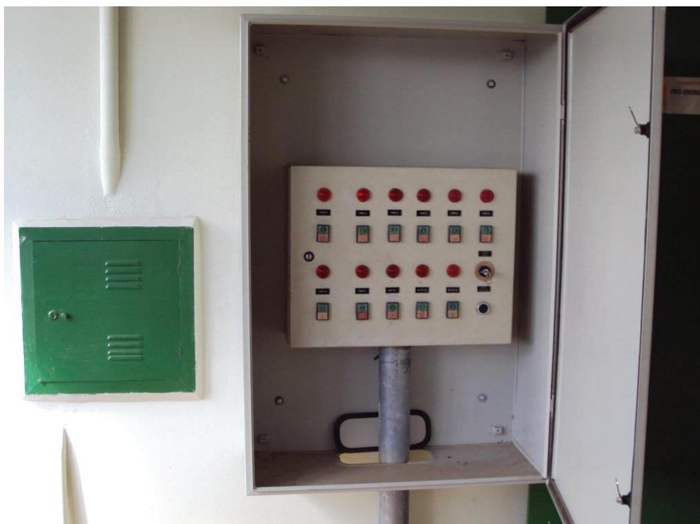
Foto 24 - Acionamento sistema de iluminação instalado em uma das cabines
