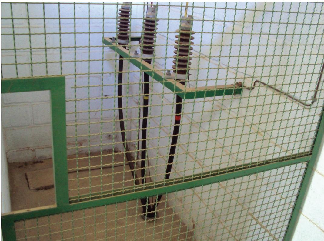
Foto 20 - Primeira subestação - Saída em média tensão (23kV) para segunda subestação
