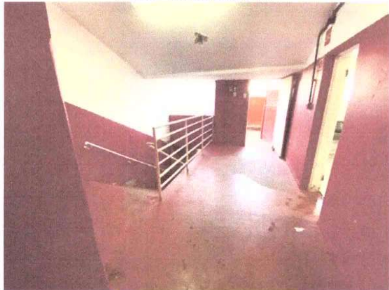
Foto 06: Acesso ao campo – vestiário mandante
