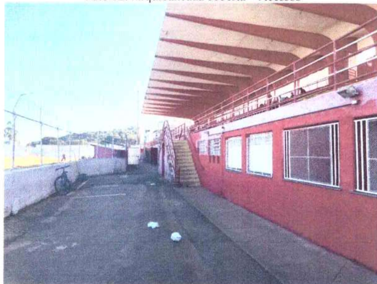
Foto 03: Arquibancada Coberta – Acessos e bar
