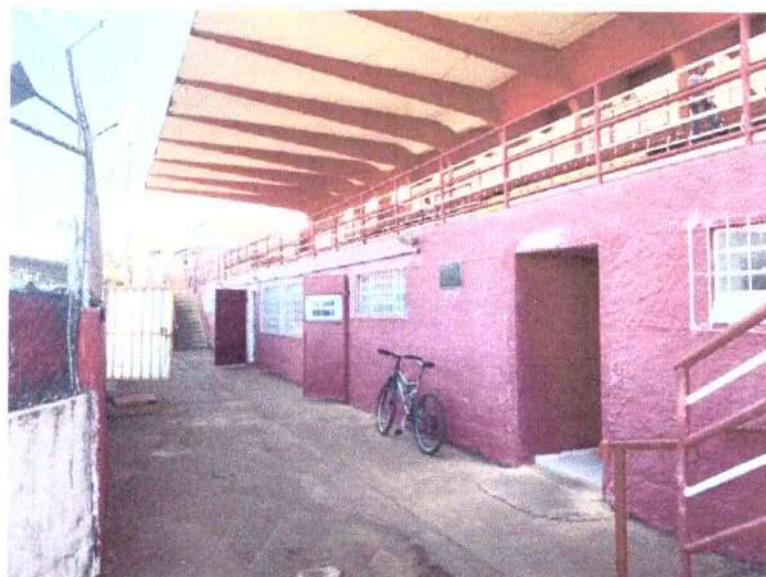
Foto 04: Arquibancada coberta - banheiros
