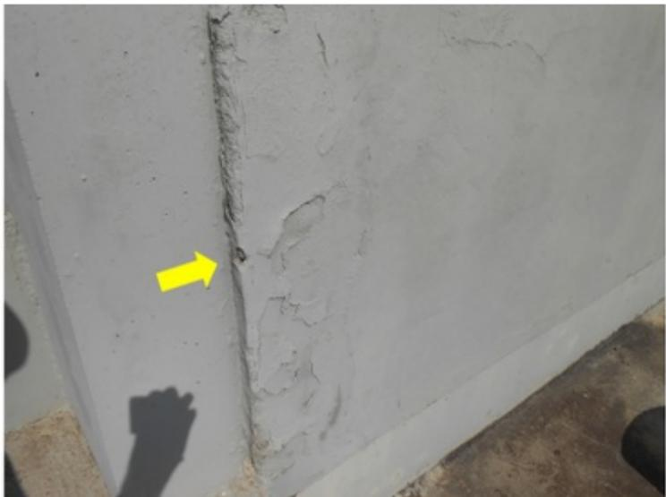
**F070** - SETOR 1 / ARQUIBANCADA - Infiltração no muro advinda das falhas na vedação da fixação do alambrado no mesmo.
