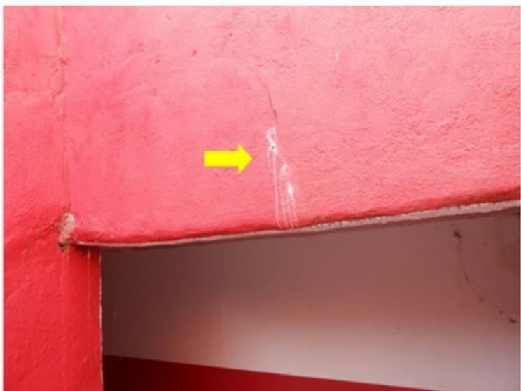
**F184** - SETOR 3 / TÚNEL DE ACESSO AO CAMPO - Infiltração e fissura na alvenaria.
