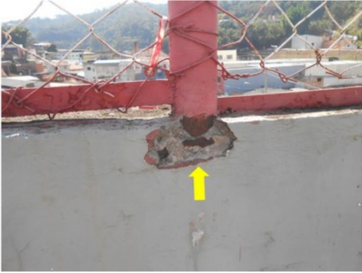
**F050** - SETOR 3 / ARQUIBANCADA - Pontos deteriorados entre o concreto e o alambrado.
