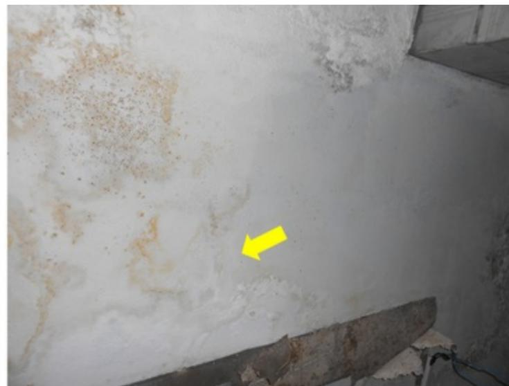
**F129** - SETOR 2 / COZINHA - Infiltração, armação exposta, revestimentos com som cavo, devido ao telhado danificado e tubulação do ladrão de água direcionado p...
