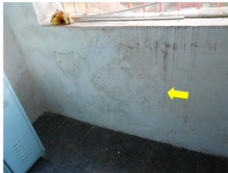
**F141** - SETOR 2 / BANHEIRO MASCULINO E FEMININO - Infiltração na laje advinda a falhas da impermeabilização da arquibancada.
