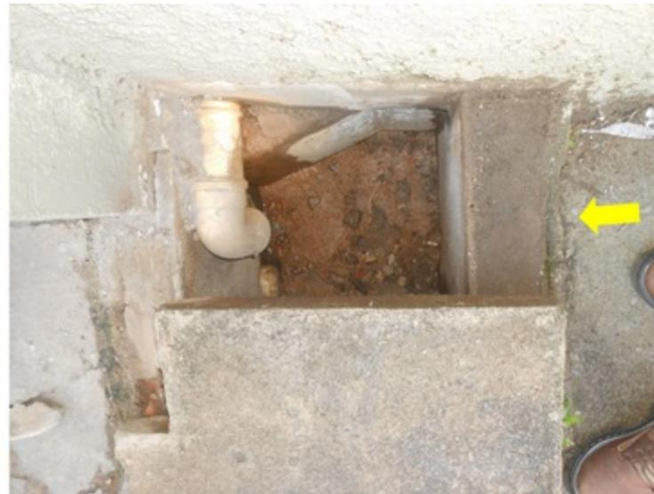
**F123** - SETOR 1 / PASSEIO EXTERNO - Vazamento na tubulação localizada dentro da caixa de passagem.
