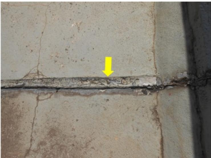
**F036** - SETORES 1,2 e 3/ ARQUIBANCADAS - Junta de dilatação com preenchimento trincado e ressecado, favorecendo a infiltração.
