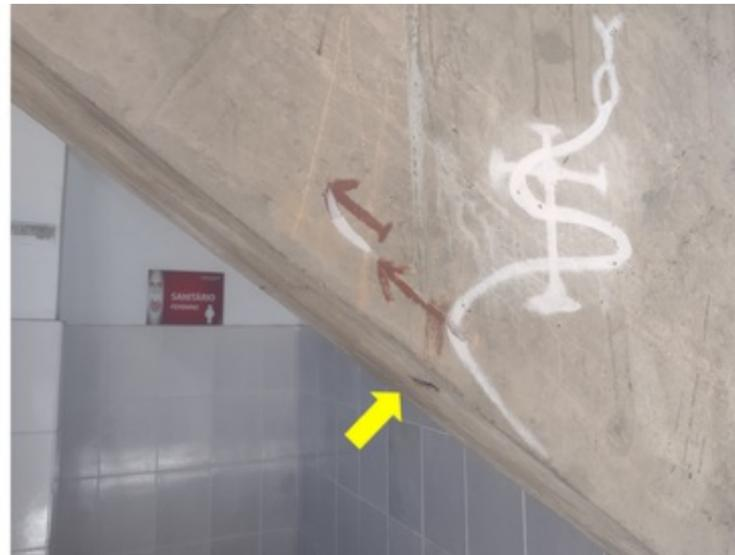
**F021** - SETOR 1 / SALA GERÊNCIA - Armação exposta na laje devido a infiltração ocasionada por vazamento na tubulação.
