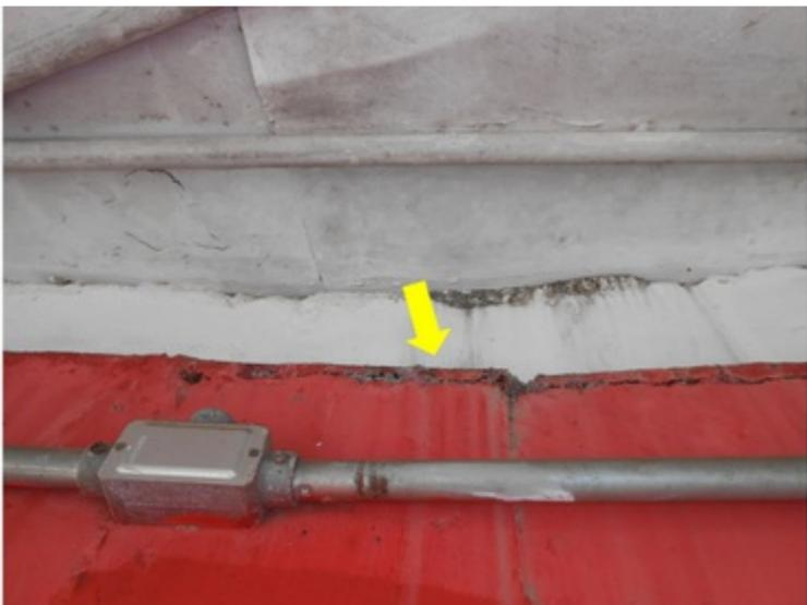
**F054** - SETORES 1 e 2 / ARQUIBANCADA - Infiltração na viga devido as falhas de vedação das chapas metálicas do telhado.
