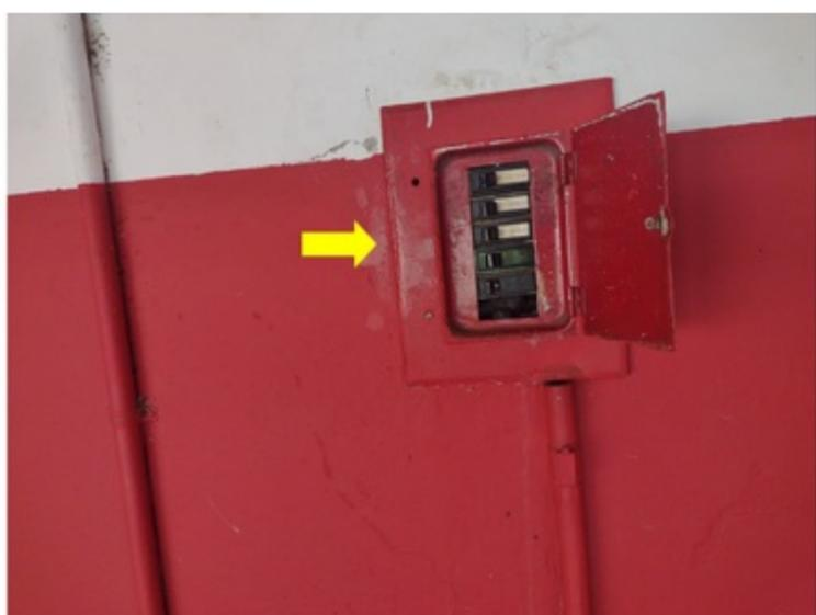
**F006** - SETOR 1 / CIRCULAÇÃO - Quadro de distribuição sem identificação/ circuitos sem identificação e sem barramento PE
