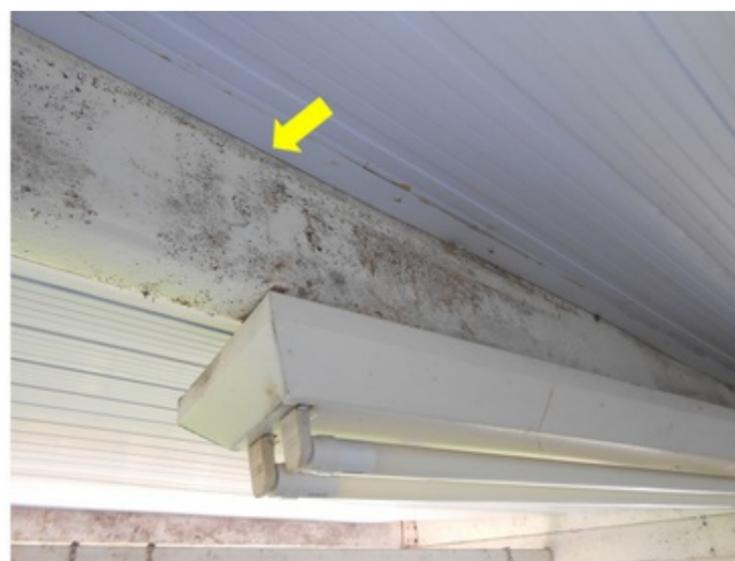
**F005** - SETOR 2 / SALA IMPRENSA - Terça do telhado está oxidada nas cabines 6, 9 e 10.
