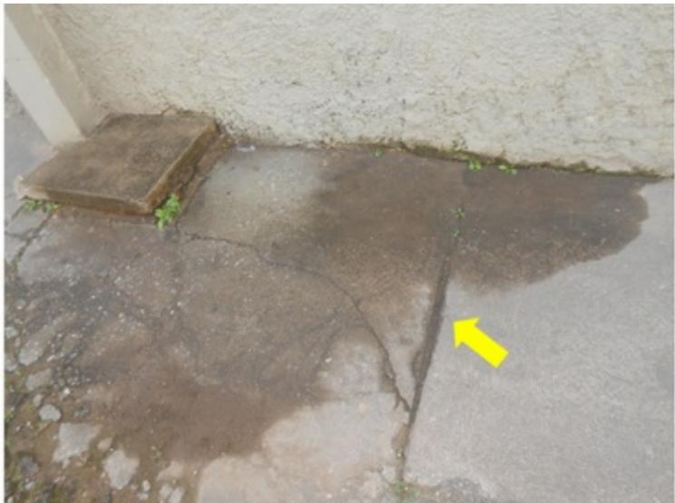
**F122** - SETOR 1 / PASSEIO EXTERNO - Vazamento na tubulação localizada dentro da caixa de passagem.
