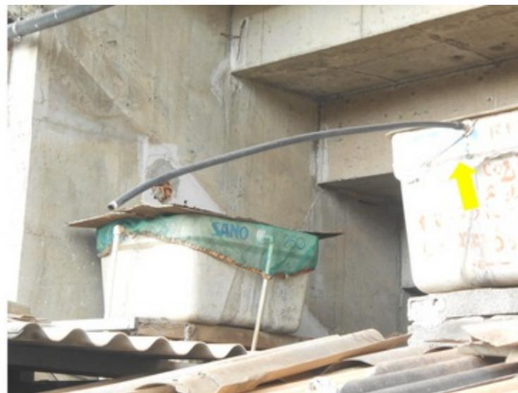
**F135** - SETOR 2 / COZINHA - Infiltração, armação exposta, revestimentos com som cavo, devido ao telhado danificado e tubulação do ladrão de água direcionado p...
