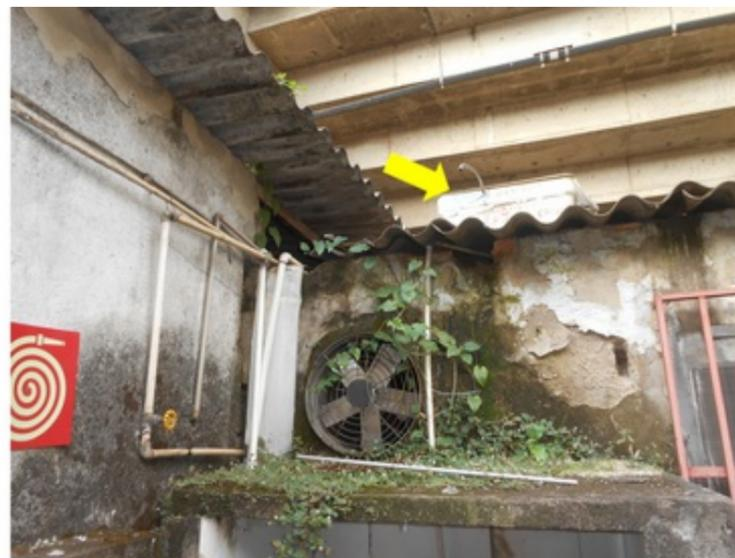
**F015** - SETOR 2 / ENTRADA SALA IMPRENSA - Tubulação do ladrão das caixas d'água estão direcionadas para o telhado, ocasionando infiltração.
