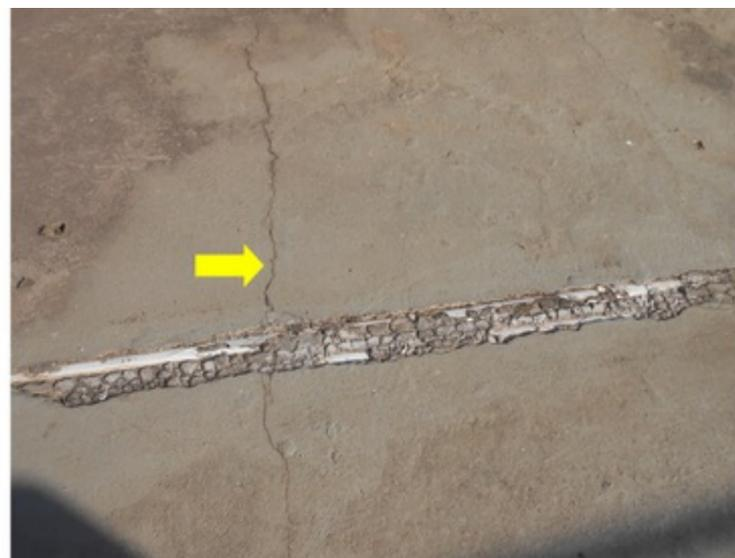
**F003** - SETORES 1,2 e 3 - Trincas e fissuras no piso.
