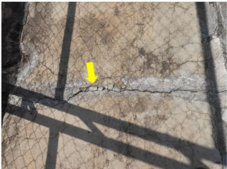
**F018** - SETORES 1,2 e 3 / ARQUIBANCADAS - Concreto deteriorado e manta exposta e soltando no piso da arquibancada.
