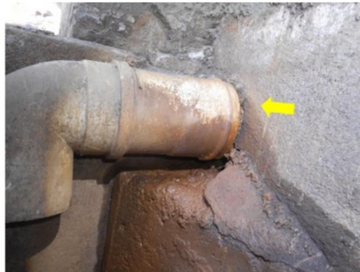
**F125** - SETOR 1 / ESCADA PARA ARQUIBANCADAS - Infiltração na área inferior da escada.
