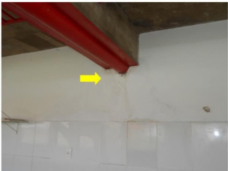
**F164** - SETOR 2 / BAR GERAL - Infiltração na laje e na alvenaria devido as falhas na impermeabilização da arquibancada.
