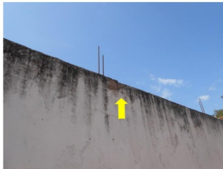
**F063** - SETORES 1 e 2 / PASSEIO EXTERNO - Ausência de pingadeira no muro, ocasionando infiltração.
