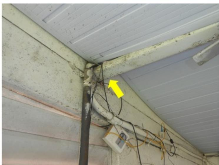
**F006** - SETOR 2 / SALA IMPRENSA - Terça do telhado está oxidada nas cabines 6, 9 e 10.
