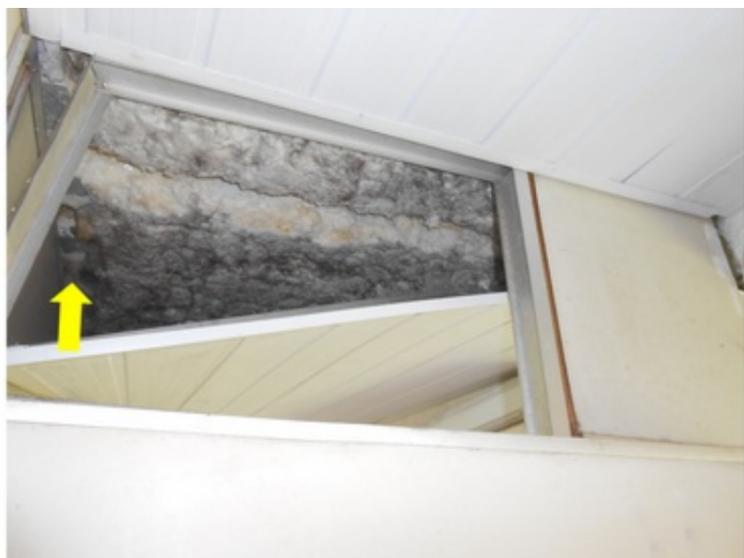
**F002** - SETOR 2 / SALA IMPRENSA - Terça do telhado está oxidada nas cabines 6, 9 e 10.
