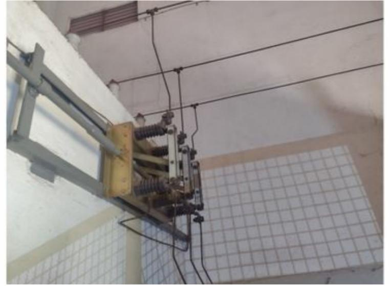
**F069** - SUBESTAÇÃO DE ENERGIA - Quadro de carga sujo/ sem identificação/ circuitos sem identificação.
