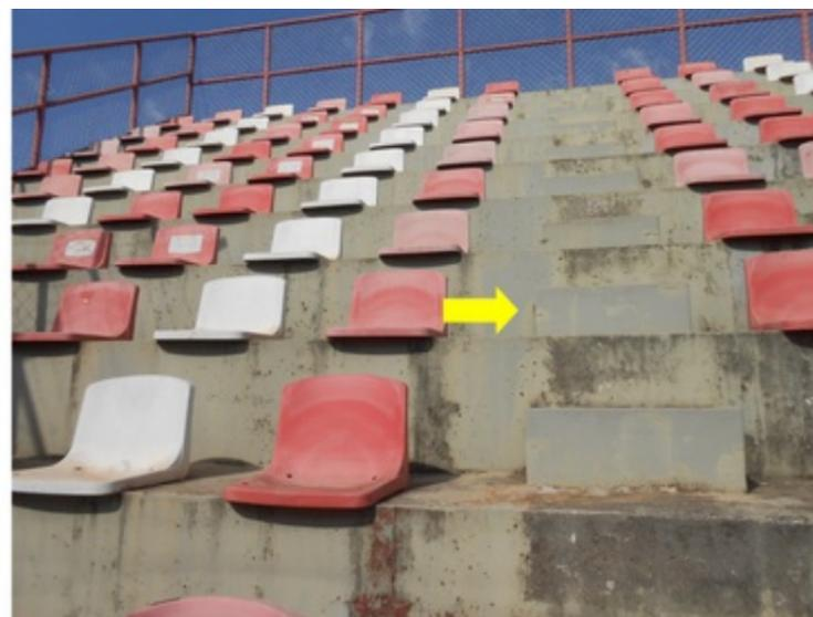
**F003** - SETORES 1,2 e 3 / ARQUIBANCADA - Pontos no alambrado com espaçamento de 16cm, se tornando inseguro para os usuários.
