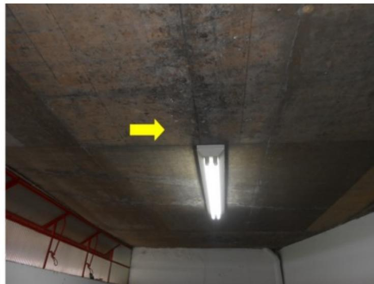
**F165** - SETOR 2 / BAR GERAL - Infiltração na laje e na alvenaria devido as falhas na impermeabilização da arquibancada.
