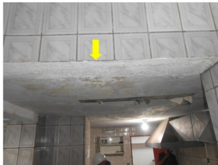
**F131** - SETOR 2 / COZINHA - Infiltração, armação exposta, revestimentos com som cavo, devido ao telhado danificado e tubulação do ladrão de água direcionado p...
