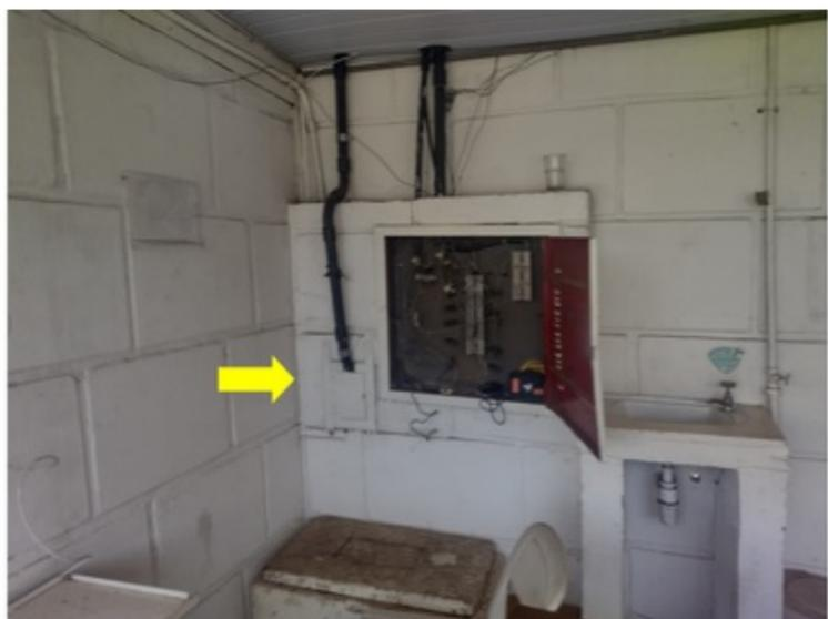
**F024** - SETOR 2 / IMPRENSA - Quadro sujos/ desorganizados/ sem identificação e sem barramento PE.
