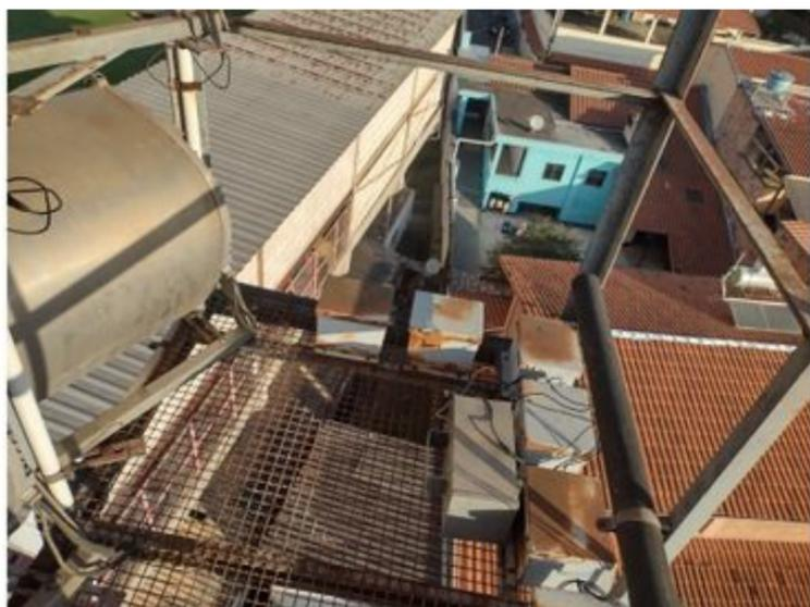
**F048** - SETOR 3 / DOCA - Uso inadequado da caixa de passagem/ espelho mal fixado.
