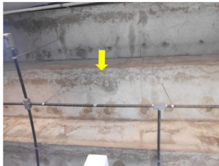
**F015** - SETOR 1 / BANHEIRO MASCULINO, FEMININO E BAR - Eflorescência, concreto escamando e armação exposta devido as falhas na impermeabilização da arquibanca...
