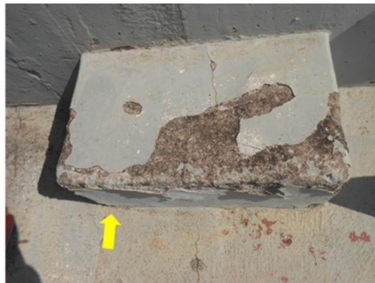
**F027** - SETORES 1,2 e 3 / ARQUIBANCADAS - Concreto deteriorado e manta exposta e soltando no piso da arquibancada.
