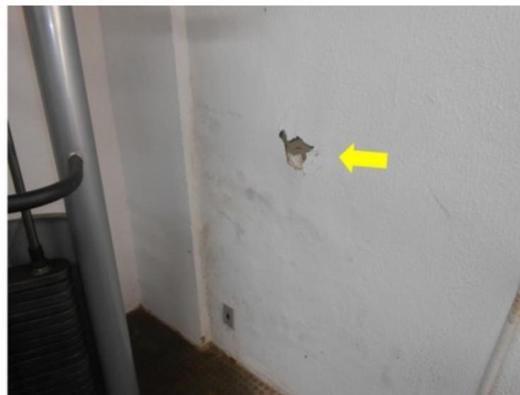
**F173** - SETOR 3 / ARQUIBANDAS - Infiltração na alvenaria que está sendo fixado o alambrado, ocasionando a perda de desempenho da mesma.
