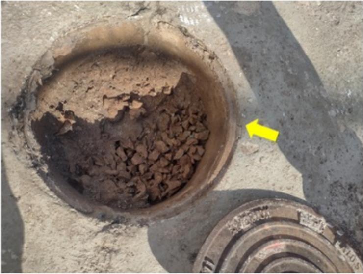
**F064** - SETOR 3 / ÁREA PRÓXIMA A SUBESTAÇÃO - Caixa de inspeção suja/ conector com indícios de corrosão.
