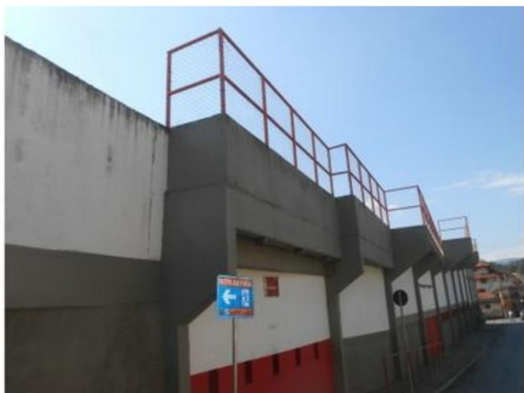
**F060** - SETORES 1 e 2 / ARQUIBANCADA - Ausência de sistema de drenagem adequado no passeio externo e água escoada no pé do muro do estádio.
