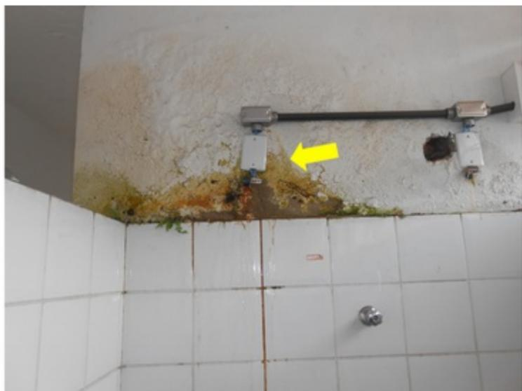
**F178** - SETOR 3 / ÁREA VISITANTES - Infiltração na alvenaria devido à ausência de chuveiro e/ou tamponamento da tubulação, permitindo que a água escoe e infil...
