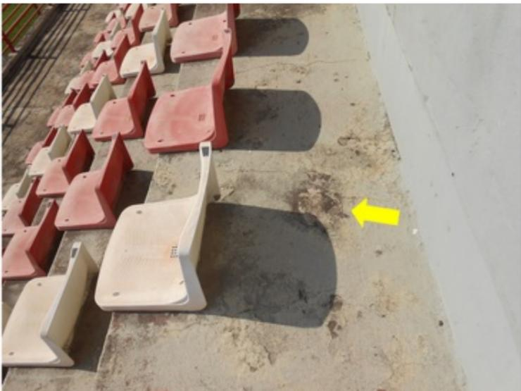
**F010** - SETORES 1,2 e 3 / ARQUIBANCADAS - Concreto deteriorado e manta exposta e soltando no piso da arquibancada.
