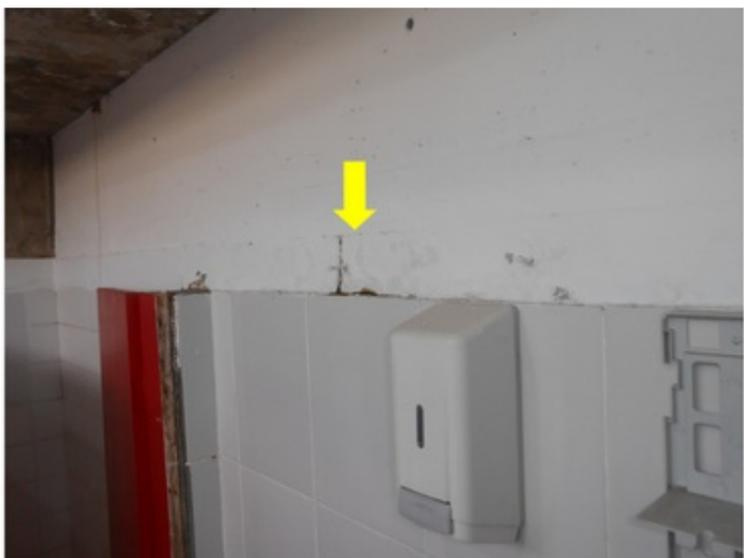
**F016** - SETOR 1 / BANHEIRO MASCULINO, FEMININO E BAR - Eflorescência, concreto escamando e armação exposta devido as falhas na impermeabilização da arquibanca...
