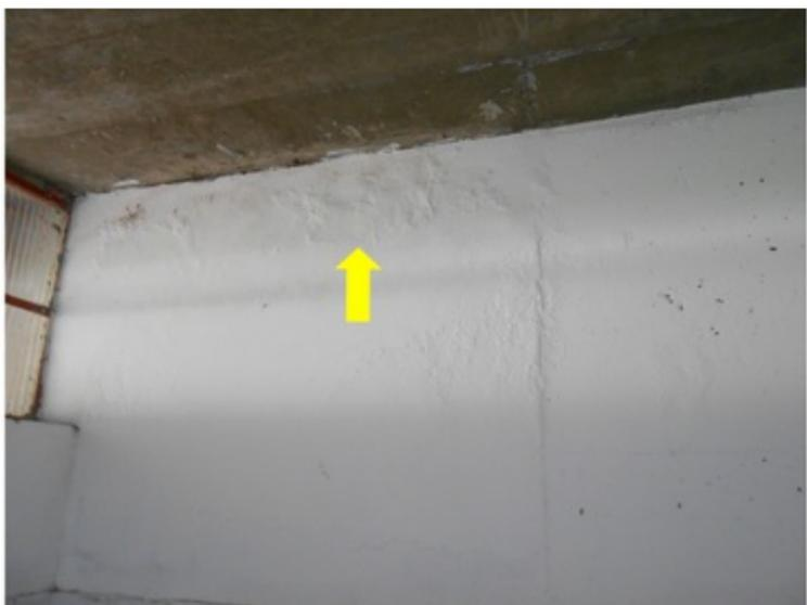
**F166** - SETOR 2 / SANITÁRIO FEMININO - Infiltração na laje devido as falhas na impermeabilização da arquibancada.
