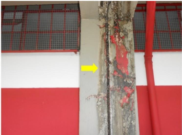
**F038** - SETORES 1,2 e 3/ ARQUIBANCADAS - Pontos danificados entre o alambrado e o piso, permitindo a infiltração de água no local.
