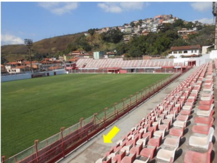
**F024** - SETORES 1,2 e 3 / ARQUIBANCADAS - Concreto deteriorado e manta exposta e soltando no piso da arquibancada.
