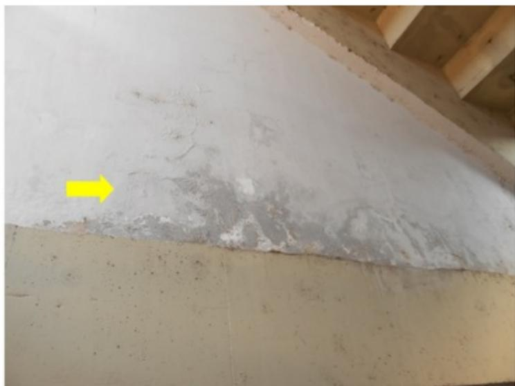
**F118** - SETOR 1 / SALA GERÊNCIA - Infiltração na alvenaria confrontante com a arquibancada, advinda das falhas da impermeabilização da arquibancada.
