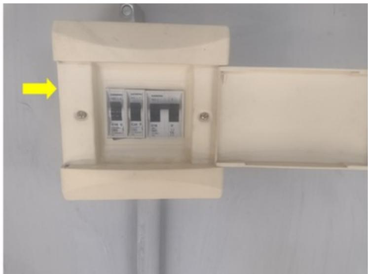
**F008** - SETOR 1/ VESTIÁRIO - Quadro de comando da bomba sem identificação/ circuitos sem identificação e sem barramento PE.
