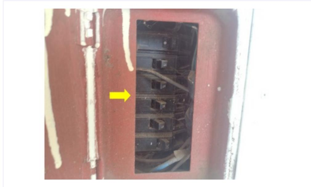
**F026** - SETOR 2/ IMPRENSA - Quadro de distribuição sem identificação/ circuitos sem identificação.
