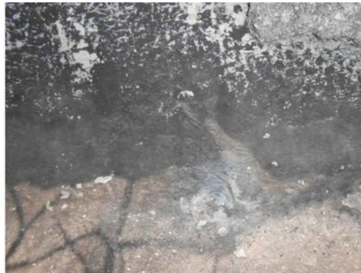
**F017** - SETORES 1,2 e 3 / ARQUIBANCADAS - Concreto deteriorado e manta exposta e soltando no piso da arquibancada.
