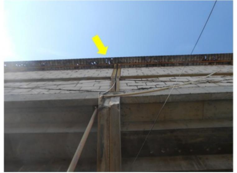
**F009** - SETOR 2 / ENTRADA SALA IMPRENSA - Telhado com pontos danificados e terça está oxidada.
