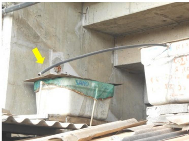
**F016** - SETOR 2 / ENTRADA SALA IMPRENSA - Tubulação do ladrão das caixas d'água estão direcionadas para o telhado, ocasionando infiltração.
