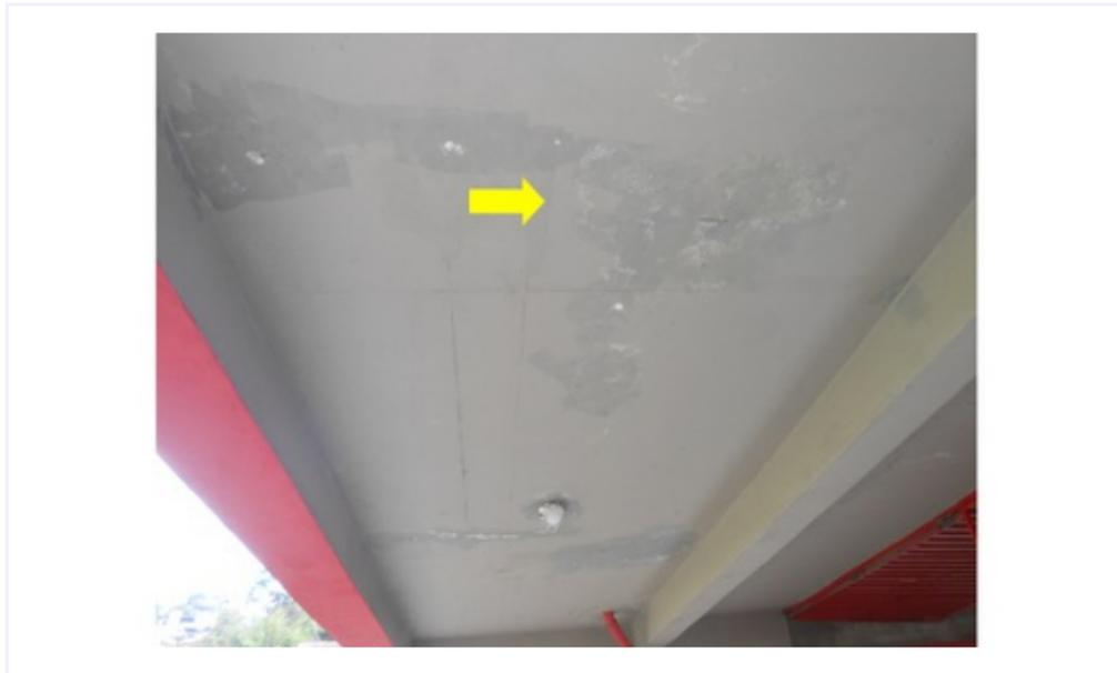
**F036** - SETOR 2 - Eflorescência, concreto escamando e armação exposta devido as falhas na impermeabilização da arquibancada.
