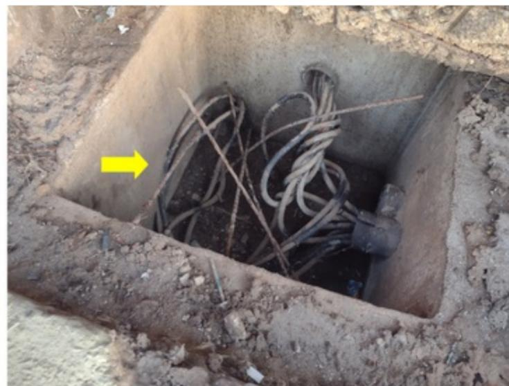
**F017** - SETOR 1 / TÚNEL DE ACESSO - Caixa de passagem mal fixada/ conexões inadequadas do eletroduto.
