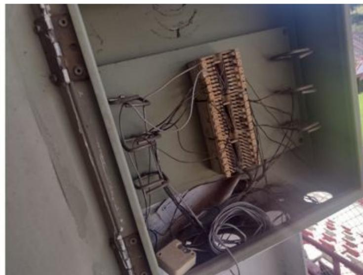
**F023** - SETOR 2 / IMPRENSA - Quadro sujos/ desorganizados/ sem identificação e sem barramento PE.
