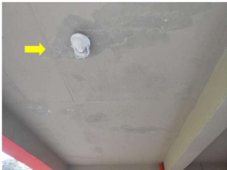
**F038** - SETOR 2 - Eflorescência, concreto escamando e armação exposta devido as falhas na impermeabilização da arquibancada.
