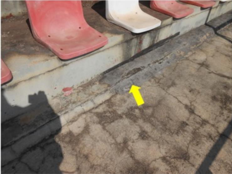
**F008** - SETORES 1,2 e 3 / ARQUIBANCADAS - Infiltração de água na laje das arquibancadas, através das perfurações na manta para fixação das cadeiras .
