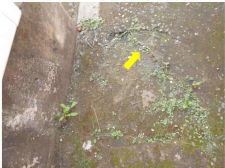
**F158** - SETOR 2 / ENTRADA SALA IMPRENSA - Empoçamento de água na laje acima do tanque ocasionando infiltração e presença de lodo.
