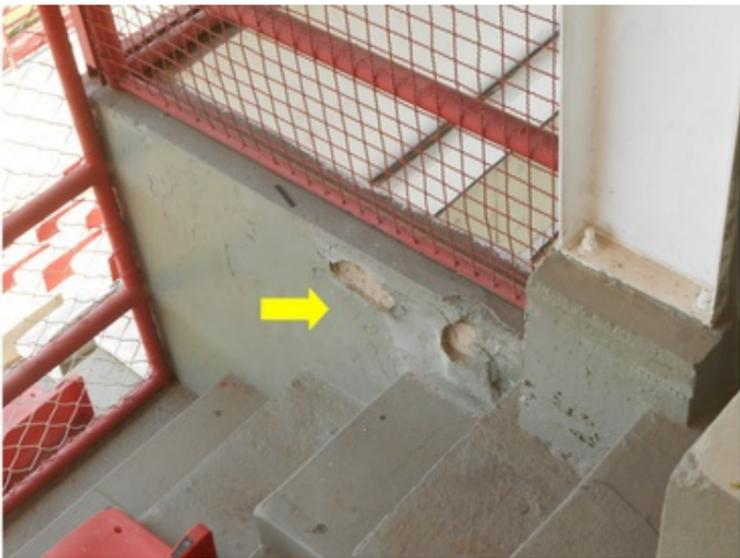
**F154** - SETOR 2 / ENTRADA IMPRENSA - Infiltração e fissuras.
