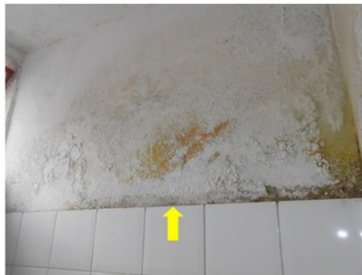
**F179** - SETOR 3 / TÚNEL DE ACESSO AO CAMPO - Infiltração na laje devido ao jardim localizado na área superior.
