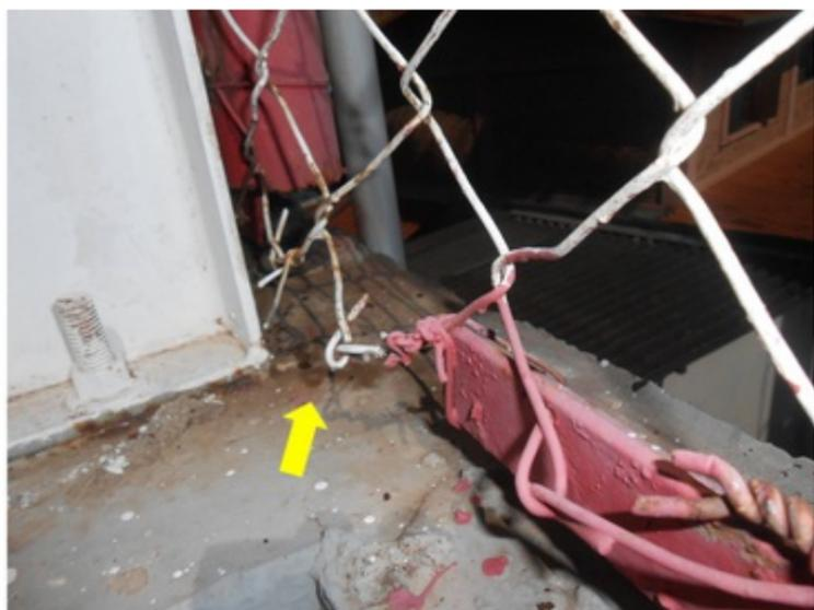
**F006** - SETOR 2 / ARQUIBANCADA - Ausência de continuidade na estrutura do alambrado.
