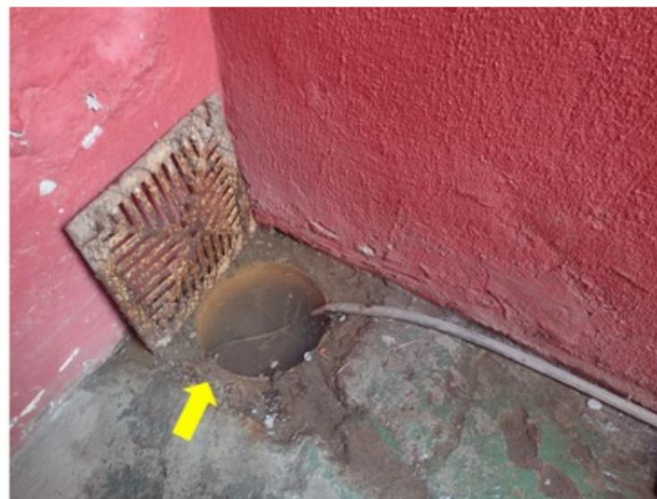
**F059** - SETOR 3 / TÚNEL DE ACESSO - Caixa de inspeção suja/ sem tampa.
