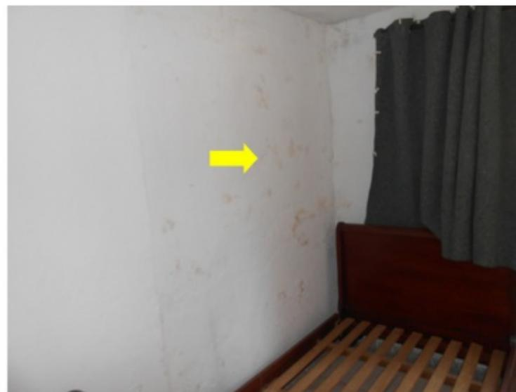
**F161** - SETOR 2 / ALOJAMENTOS - Infiltração e fissuras nas alvenarias devido as falhas encontradas no telhado e piso do corredor localizado para a entrada na ...
