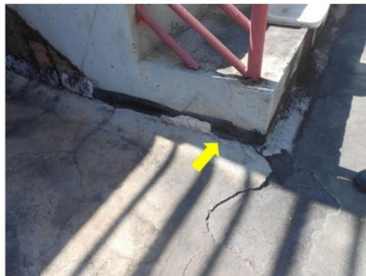
**F029** - SETORES 1,2 e 3 / ARQUIBANCADAS - Concreto deteriorado e manta exposta e soltando no piso da arquibancada.
