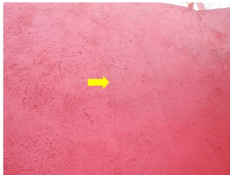
**F185** - SETOR 3 / DEPÓSITO - Infiltração na laje inferior devido a falha na impermeabilização da laje superior.
