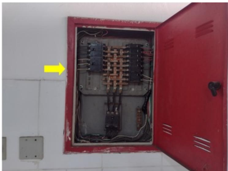
**F002** - SETOR 1 / BAR - Quadro de distribuição sem identificação/ circuitos sem identificação/ sem proteção contra toque direto e sem barramento PE.
