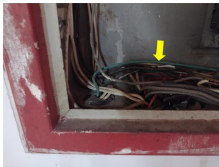
**F005** - SETOR 1 / CIRCULAÇÃO - Quadro de distribuição sem identificação/ circuitos sem identificação e sem barramento PE
