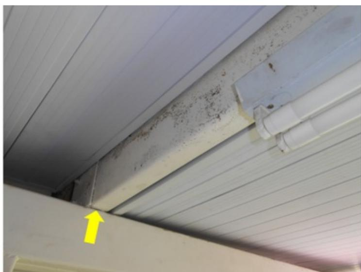
**F004** - SETOR 2 / SALA IMPRENSA - Terça do telhado está oxidada nas cabines 6, 9 e 10.
