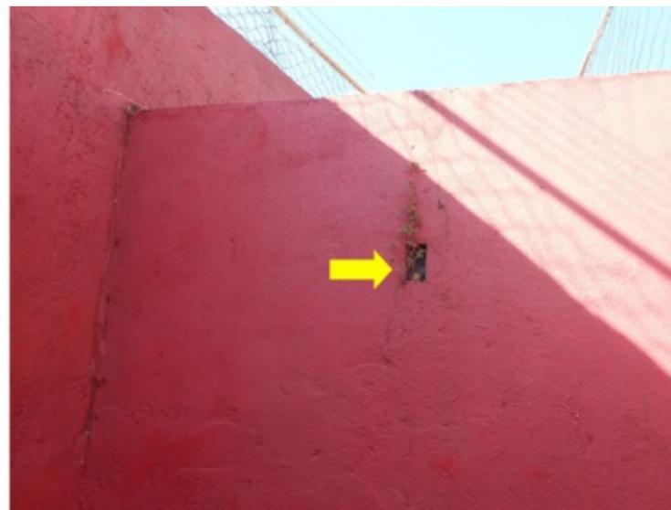
**F183** - SETOR 3 / TÚNEL DE ACESSO AO CAMPO - Infiltração e fissura na alvenaria.
