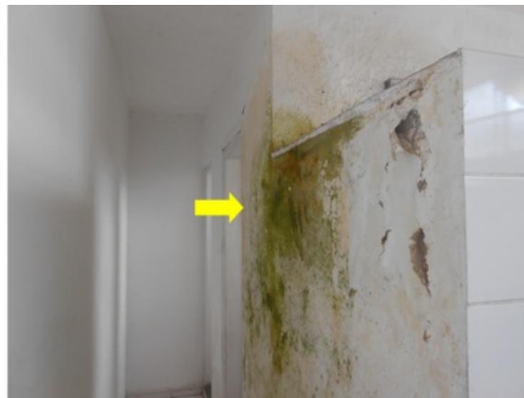
**F177** - SETOR 3 / ÁREA VISITANTES - Infiltração na alvenaria devido à ausência de chuveiro e/ou tamponamento da tubulação, permitindo que a água escoe e infil...
