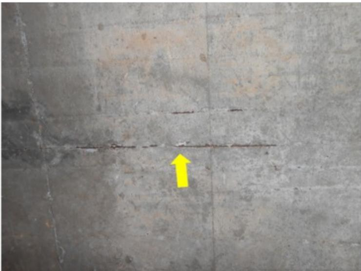
**F046** - SETOR 2 / BAR GERAL - Fissura e armação exposta.
