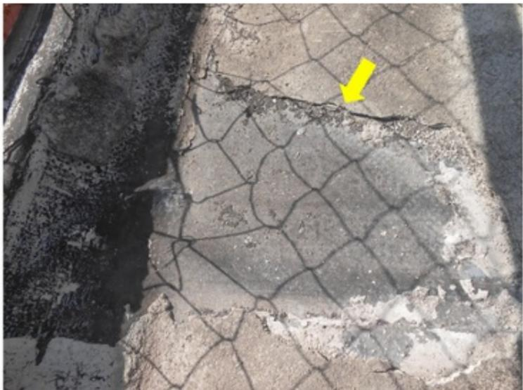
**F016** - SETORES 1,2 e 3 / ARQUIBANCADAS - Concreto deteriorado e manta exposta e soltando no piso da arquibancada.
