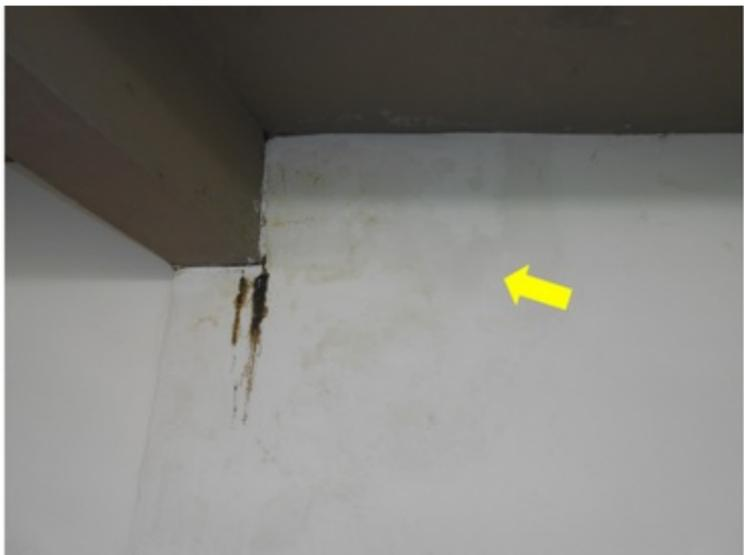
**F090** - SETOR 1 / BAR GERAL - Infiltração na laje devido as falhas na impermeabilização da arquibancada.
