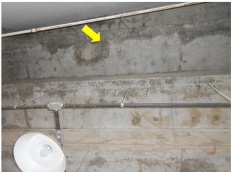
**F012** - SETOR 1 / BANHEIRO MASCULINO, FEMININO E BAR - Eflorescência, concreto escamando e armação exposta devido as falhas na impermeabilização da arquibanca...
