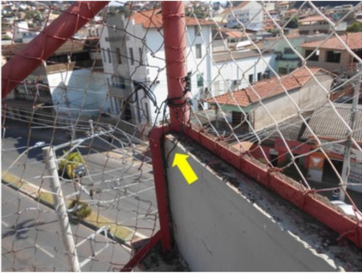
**F052** - SETOR 3 / ARQUIBANCADA - Pontos deteriorados entre o concreto e o alambrado.
