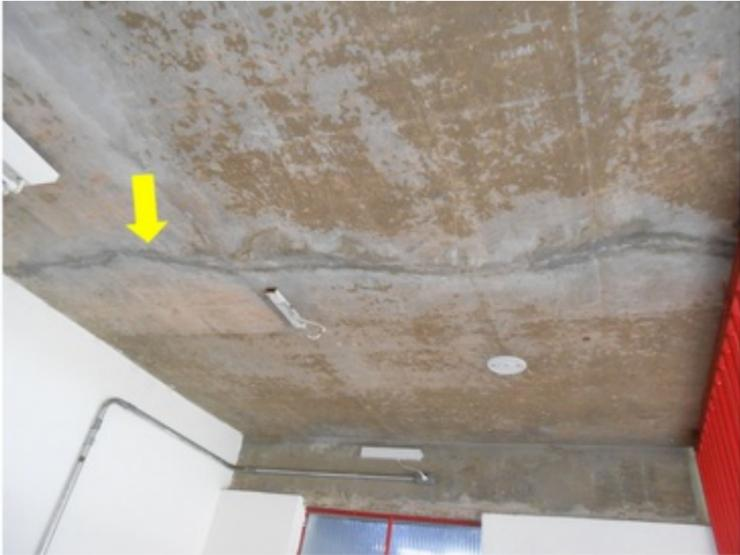
**F044** - SETOR 2 / BAR GERAL - Fissura e armação exposta.
