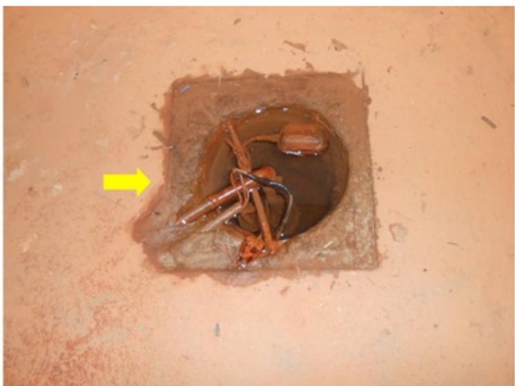
**F048** - SETORES 1 e 2/ ARQUIBANCADAS - Infiltração no muro advinda da drenagem inadequada do passeio externo.
