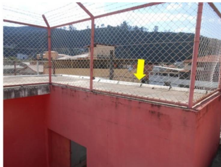
**F077** - SETOR 1 / SALA CAMAROTE - Ausência de proteção mecânica na manta de impermeabilização.
