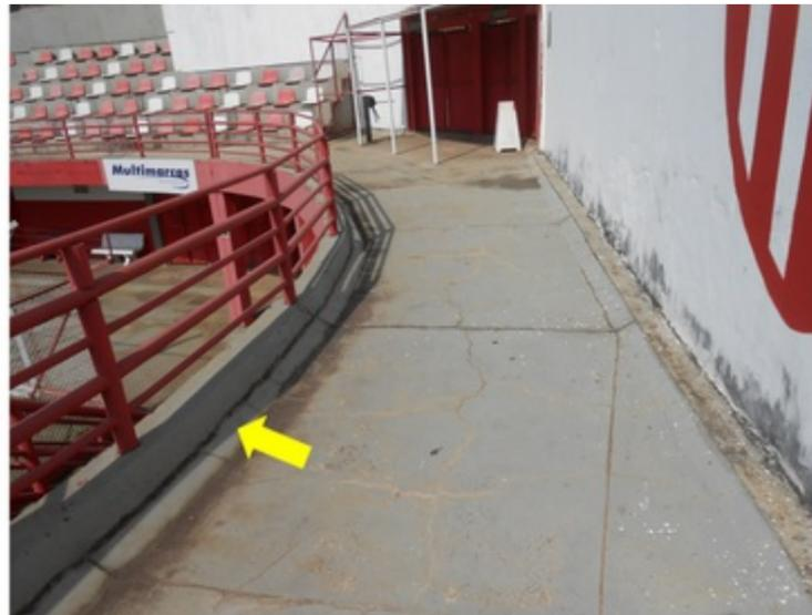
**F039** - SETORES 1,2 e 3/ ARQUIBANCADAS - Pontos danificados entre o alambrado e o piso, permitindo a infiltração de água no local.
