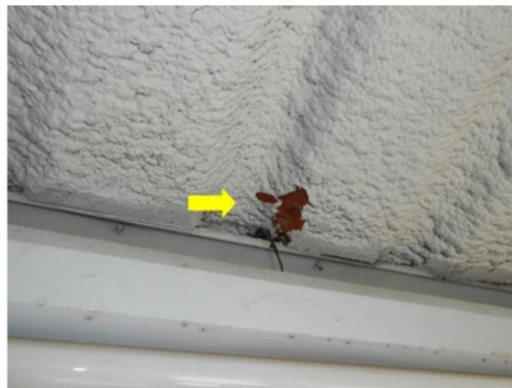
**F095** - SETOR 2 / SALA IMPRENSA - Infiltração no forro das cabines devido as falhas existentes no telhado.
