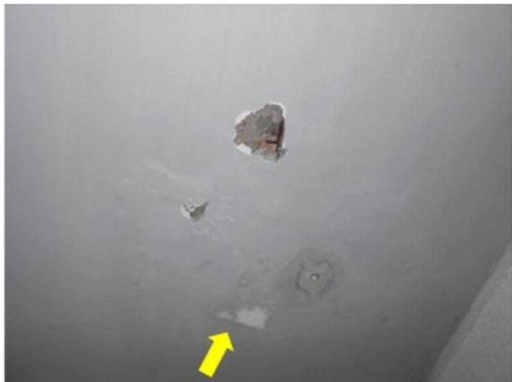
**F024** - SETOR 1 / SALA GERÊNCIA - Fissura na união de elementos estruturais diferentes.
