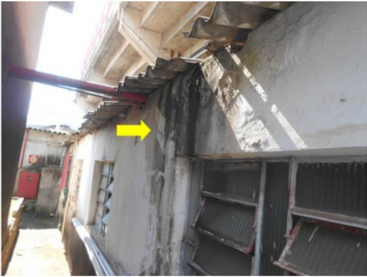
**F012** - SETOR 2 / ENTRADA SALA IMPRENSA - Telhado com pontos danificados e terça está oxidada.
