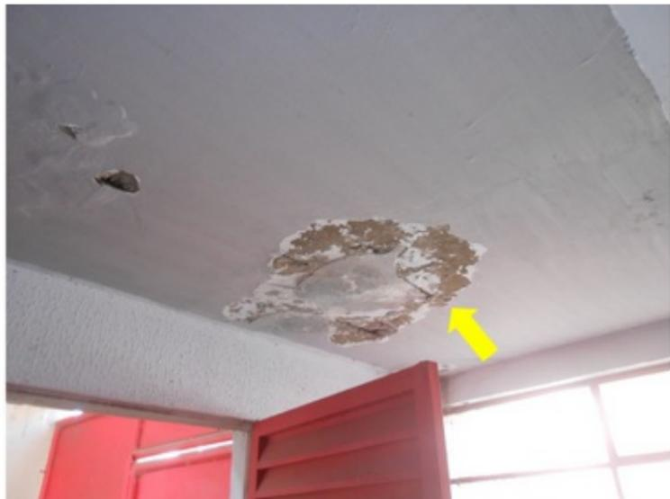
**F022** - SETOR 1 / SALA GERÊNCIA - Armação exposta na laje devido a infiltração ocasionada por vazamento na tubulação.
