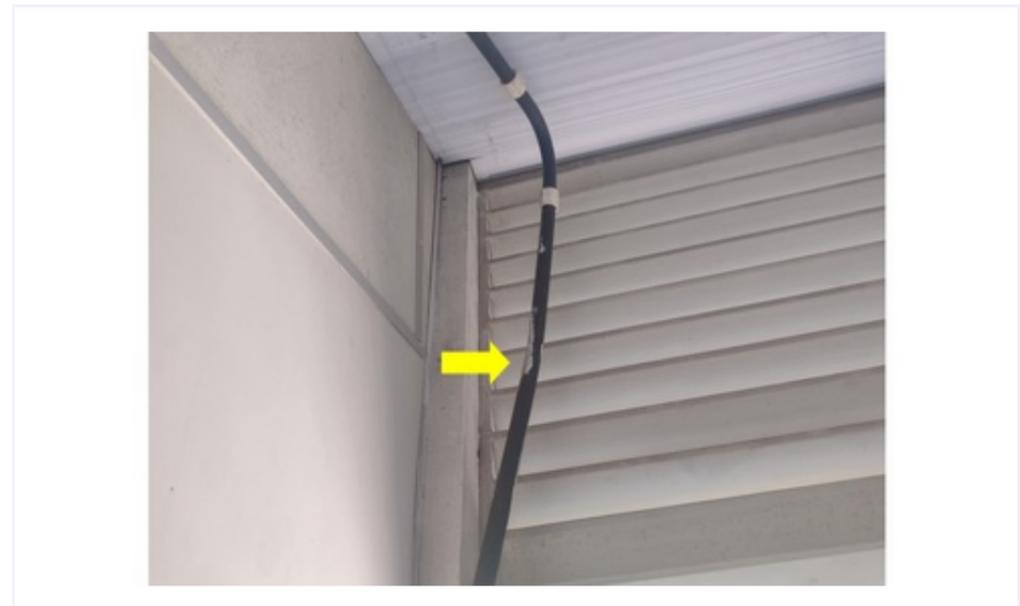
**F029** - SETOR 2/ IMPRENSA - Conexão inadequada do eletroduto.
