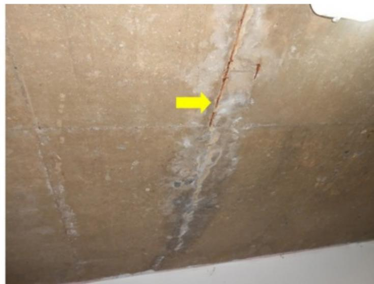
**F143** - SETOR 2 / BANHEIRO MASCULINO E FEMININO - Infiltração na laje advinda a falhas da impermeabilização da arquibancada.
