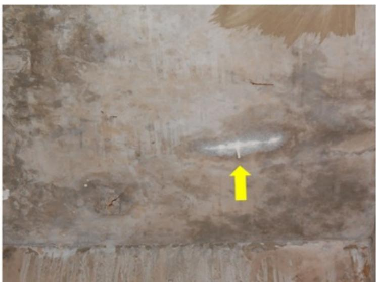
**F018** - SETOR 1/ BANHEIRO MASCULINO - Fissuras na alvenaria devido a movimentação da tubulação.
