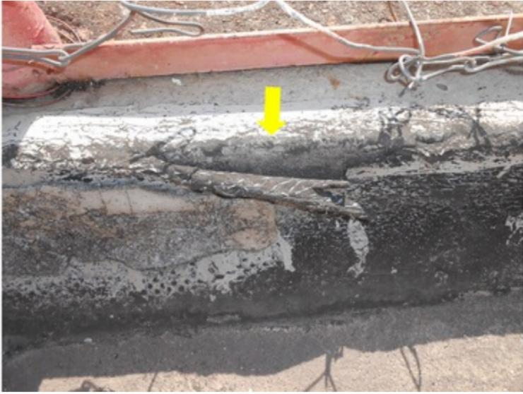
**F020** - SETORES 1,2 e 3 / ARQUIBANCADAS - Concreto deteriorado e manta exposta e soltando no piso da arquibancada.
