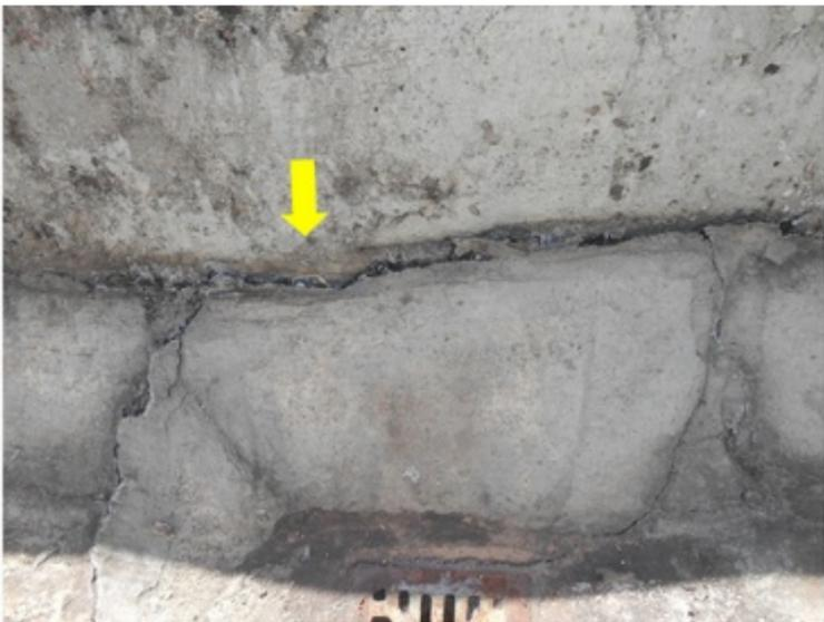
**F022** - SETORES 1,2 e 3 / ARQUIBANCADAS - Concreto deteriorado e manta exposta e soltando no piso da arquibancada.
