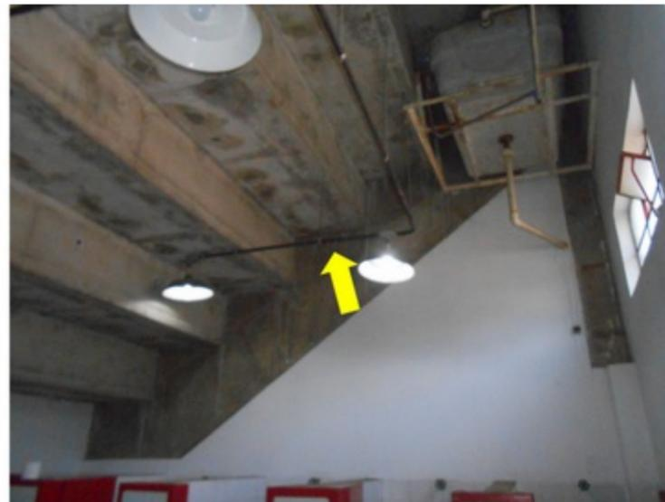
**F011** - SETOR 1 / BANHEIRO MASCULINO, FEMININO E BAR - Eflorescência, concreto escamando e armação exposta devido as falhas na impermeabilização da arquibanca...
