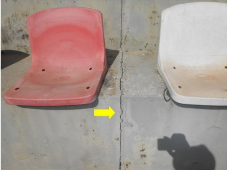
**F032** - SETORES 1,2 e 3/ ARQUIBANCADAS - Junta de dilatação com preenchimento trincado e ressecado, favorecendo a infiltração.
