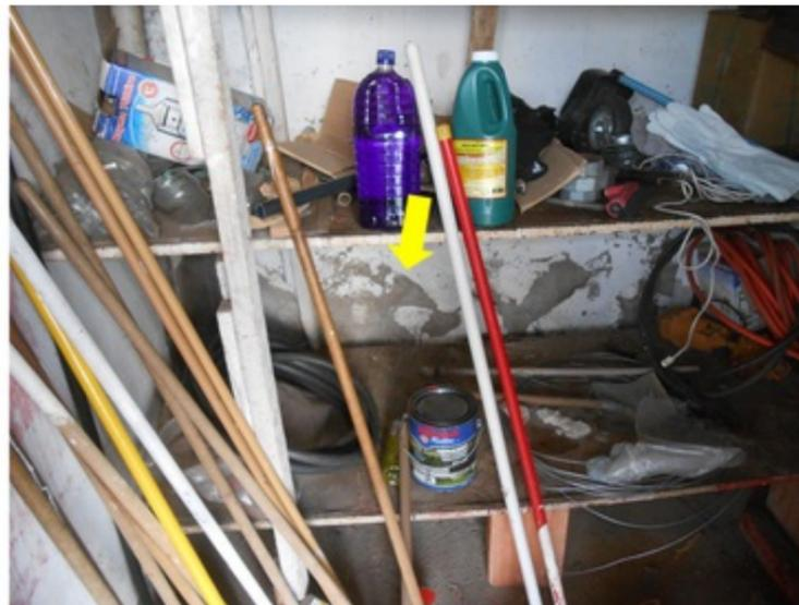
**F089** - SETOR 1 / BAR GERAL - Infiltração na laje devido as falhas na impermeabilização da arquibancada.
