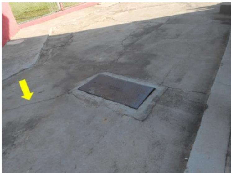
**F004** - SETORES 1,2 e 3 - Trincas e fissuras no piso.
