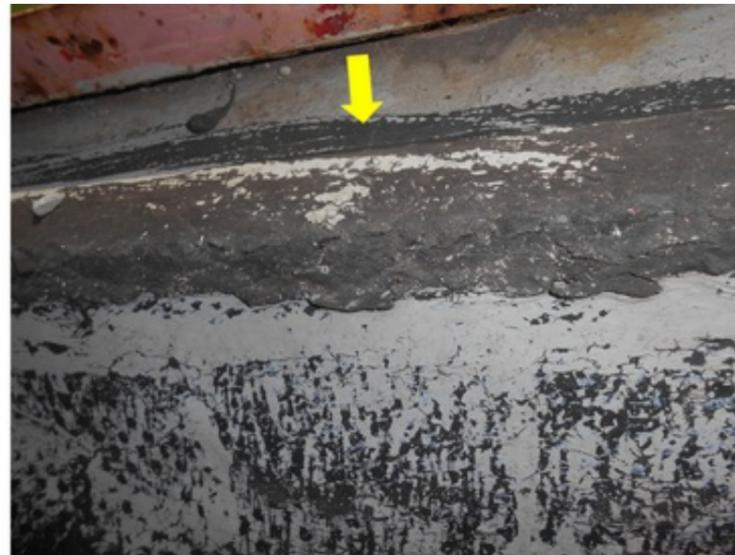
**F015** - SETORES 1,2 e 3 / ARQUIBANCADAS - Concreto deteriorado e manta exposta e soltando no piso da arquibancada.
