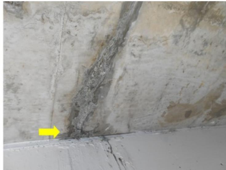
**F069** - SETOR 1 / ARQUIBANCADA - Infiltração no muro advinda das falhas na vedação da fixação do alambrado no mesmo.
