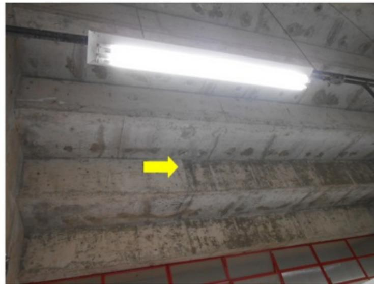
**F107** - SETOR 1 - Infiltração advinda a falhas da impermeabilização da arquibancada.
