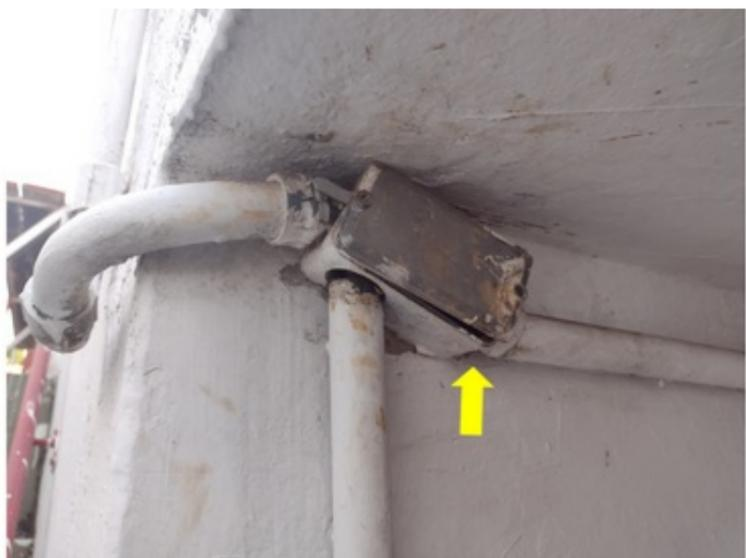
**F018** - SETOR 1 / TÚNEL DE ACESSO - Fiação da bomba em contato com a água.
