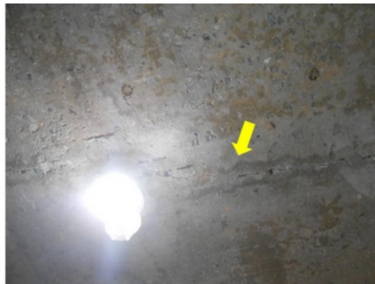
**F147** - SETOR 2 / BANHEIRO MASCULINO E FEMININO - Infiltração na laje advinda a falhas da impermeabilização da arquibancada.
