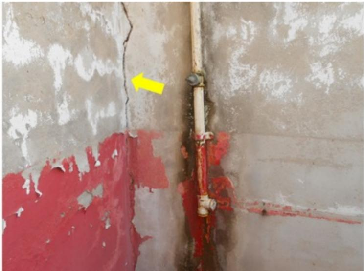
**F056** - SETOR 3 / VESTIÁRIO DESATIVADO - Trincas, infiltrações e estrutura precária do vestiário desativado.
