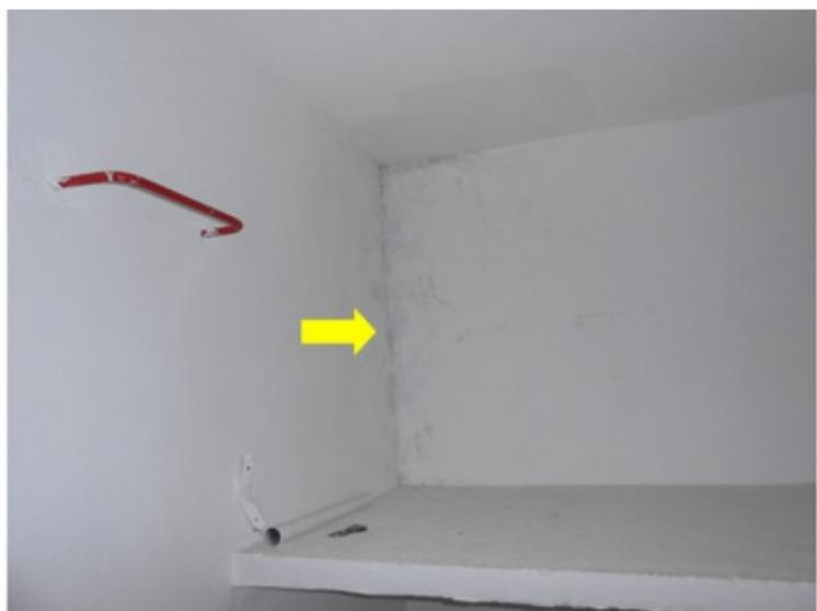
**F162** - SETOR 2 / ALOJAMENTOS - Infiltração e fissuras nas alvenarias devido as falhas encontradas no telhado e piso do corredor localizado para a entrada na ...
