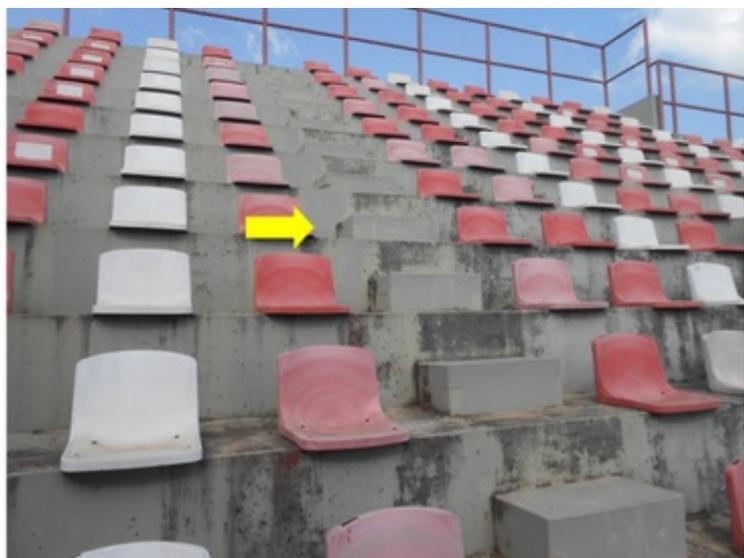
**F002** - SETORES 1,2 e 3 / ARQUIBANCADA - Inexistência de guarda corpo na escada das arquibancadas.
