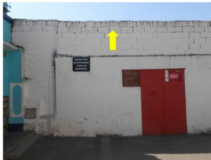
**F065** - SETOR 1 / BAR - Indícios de infiltração advinda das falhas na impermeabilização da arquibancada.
