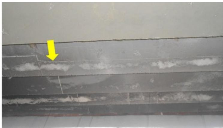
**F176** - SETOR 3 / ÁREA VISITANTES - Infiltração na alvenaria devido à ausência de chuveiro e/ou tamponamento da tubulação, permitindo que a água escoe e infil...
