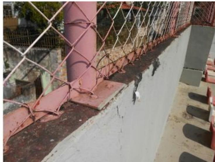
**F071** - SETOR 1 / ARQUIBANCADA - Infiltração no muro advinda das falhas na vedação da fixação do alambrado no mesmo.
