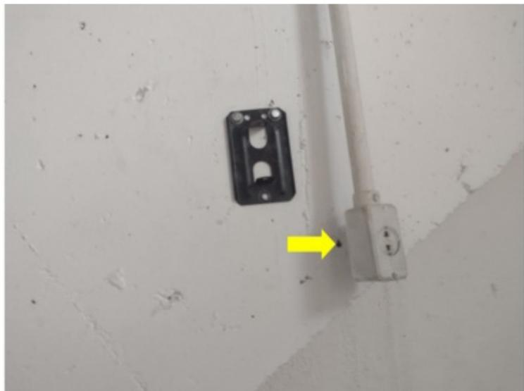
**F036** - SETOR 2 / VESTIÁRIO - Cabeamento e roteador de rede aparente/ sem fixação adequada.
