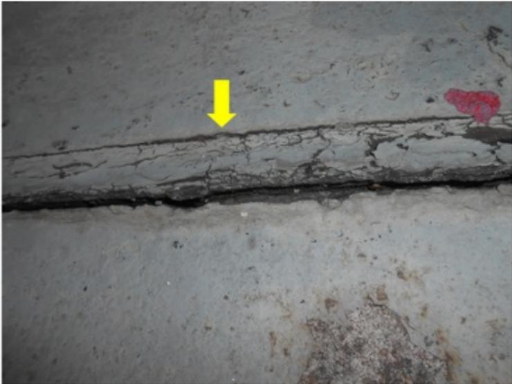
**F034** - SETORES 1,2 e 3/ ARQUIBANCADAS - Junta de dilatação com preenchimento trincado e ressecado, favorecendo a infiltração.
