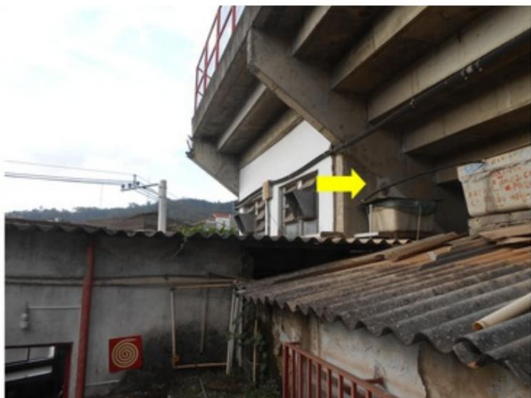
**F136** - SETOR 2 / COZINHA - Infiltração, armação exposta, revestimentos com som cavo, devido ao telhado danificado e tubulação do ladrão de água direcionado p...
