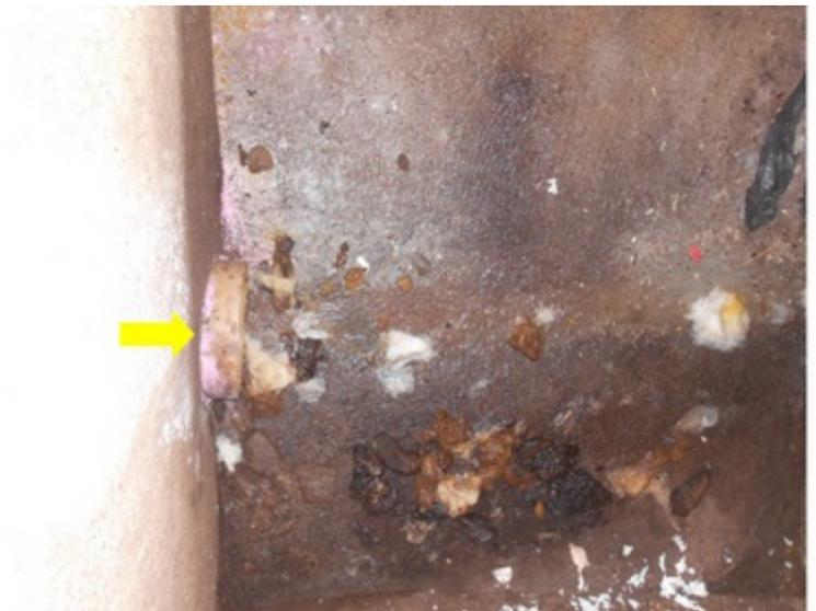
**F003** - SETOR 2 - Tubulação danificada na caixa de passagem de esgoto.
