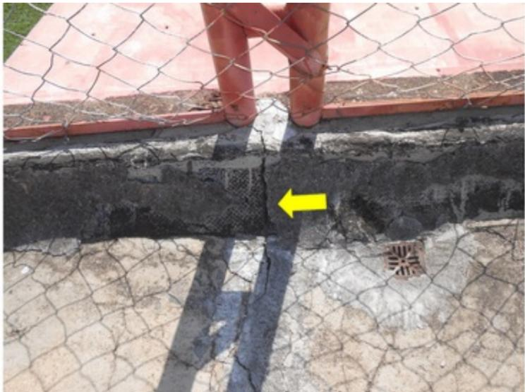
**F014** - SETORES 1,2 e 3 / ARQUIBANCADAS - Concreto deteriorado e manta exposta e soltando no piso da arquibancada.
