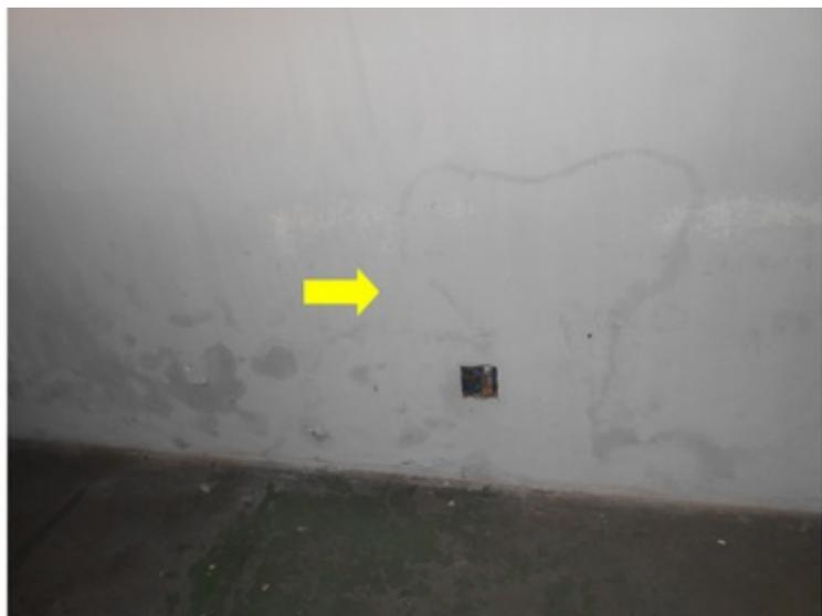
**F116** - SETOR 1 / SALA GERÊNCIA - Infiltração na área inferior da alvenaria advinda das falhas na caixa de passagem localizada no passeio externo.
