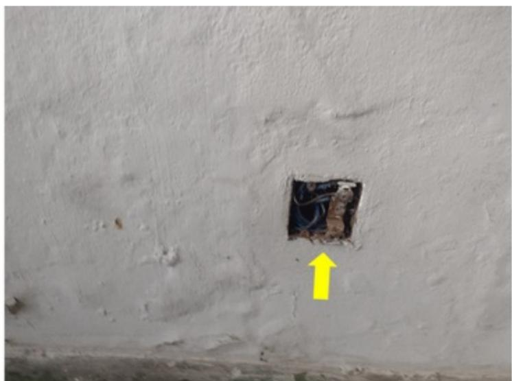
**F012** - SETOR 1 / SALA DA ARBITRAGEM - Caixa de passagem sujas próxima a indícios de infiltração.
