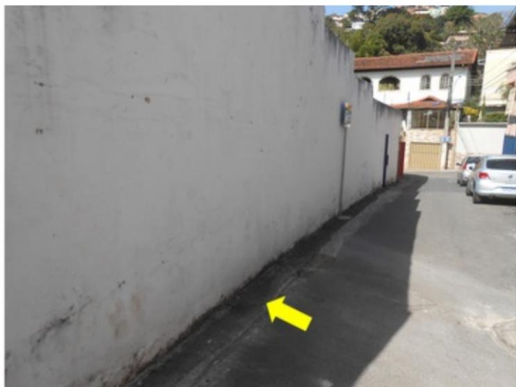
**F058** - SETORES 1 e 2 / ARQUIBANCADA - Ausência de sistema de drenagem adequado no passeio externo e água escoada no pé do muro do estádio.
