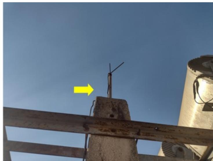
**F047** - SETOR 2/ TORRE DE ILUMINAÇÃO - Estado de conservação da torre e dos reatores depreciada.
