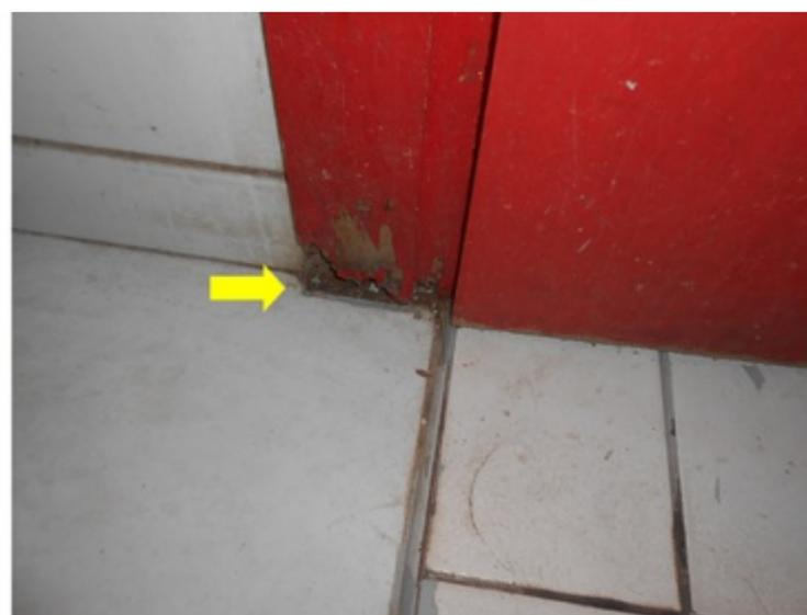
**F005** - SETOR 2 / DEPARTAMENTO MÉDICO - Desplacamento do revestimento cerâmico, devido ao vazamento na tubulação da máquina de gelo.
