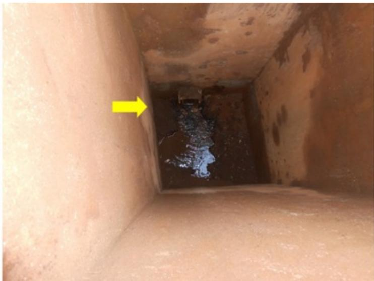
**F002** - SETOR 2 - Tubulação danificada na caixa de passagem de esgoto.
