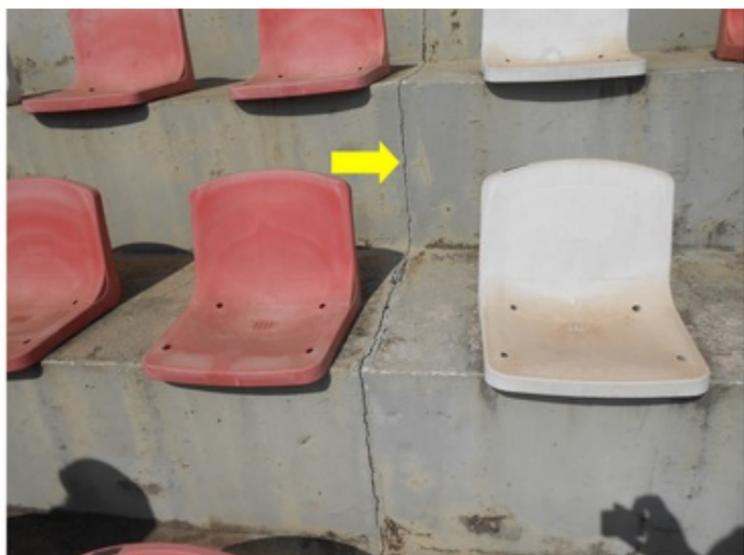
**F030** - SETORES 1,2 e 3 / ARQUIBANCADAS - Concreto deteriorado e manta exposta e soltando no piso da arquibancada.
