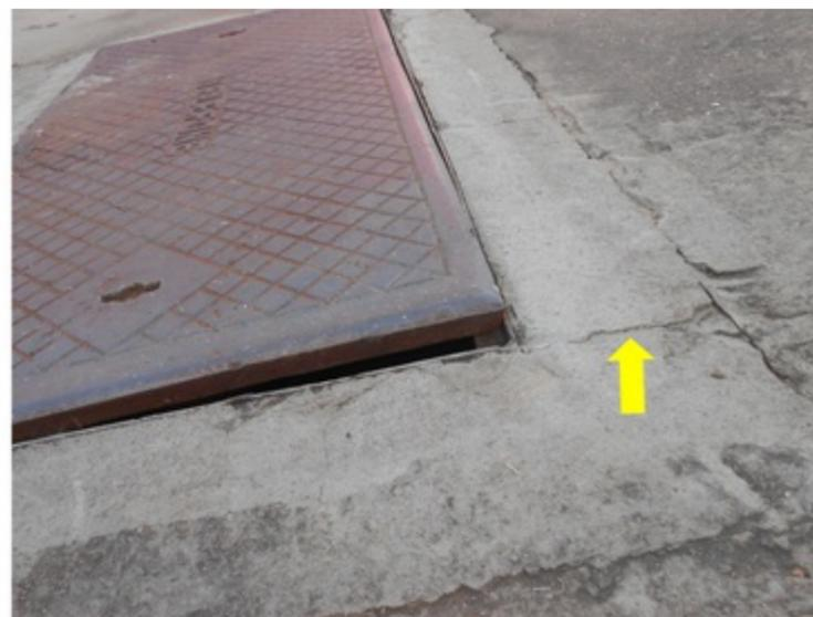
**F005** - SETORES 1,2 e 3 - Trincas e fissuras no piso.
