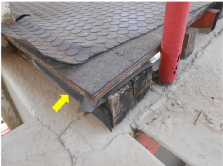
**F030** - SETOR 2 / ARQUIBANCADA - Estrutura do piso em madeira e metálica, não garantindo a segurança e estabilidade do local.
