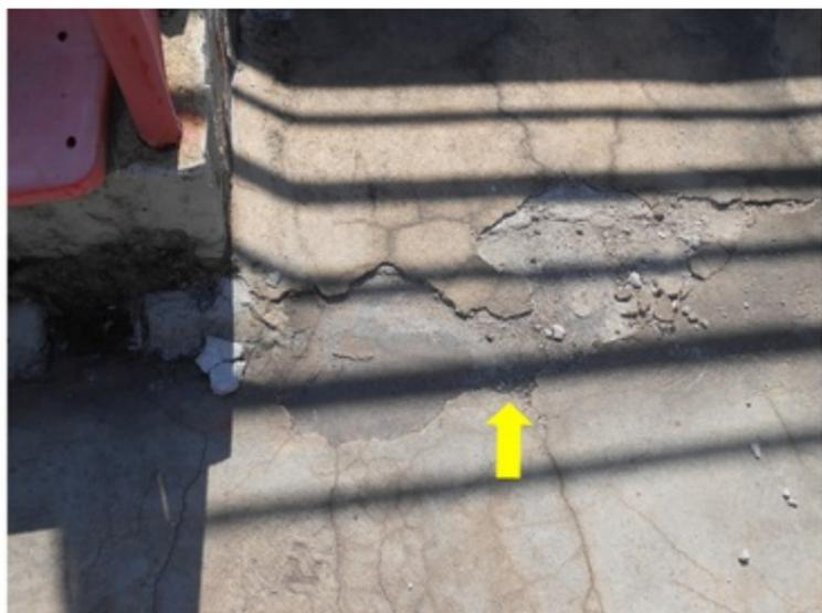
**F028** - SETORES 1,2 e 3 / ARQUIBANCADAS - Concreto deteriorado e manta exposta e soltando no piso da arquibancada.
