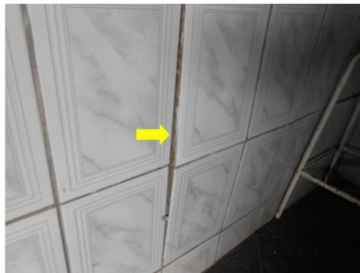
**F137** - SETOR 2 / COZINHA - Infiltração, armação exposta, revestimentos com som cavo, devido ao telhado danificado e tubulação do ladrão de água direcionado p...
