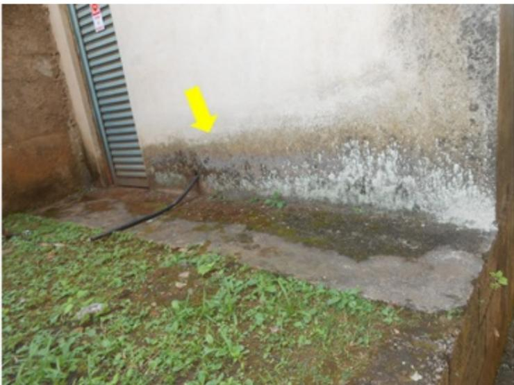
**F156** - SETOR 2 / ENTRADA SALA IMPRENSA - Infiltração, presença de lodo e trincas no piso.
