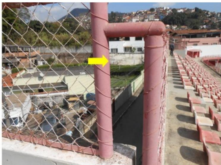
**F004** - SETORES 1,2 e 3 / ARQUIBANCADA - Pontos no alambrado com espaçamento de 16cm, se tornando inseguro para os usuários.
