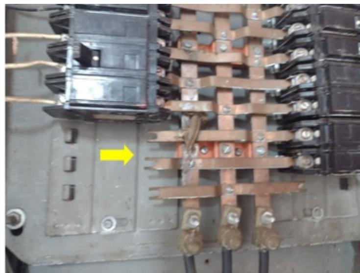
**F003** - SETOR 1 / BAR - Quadro de distribuição sem identificação/ circuitos sem identificação/ sem proteção contra toque direto e sem barramento PE.
