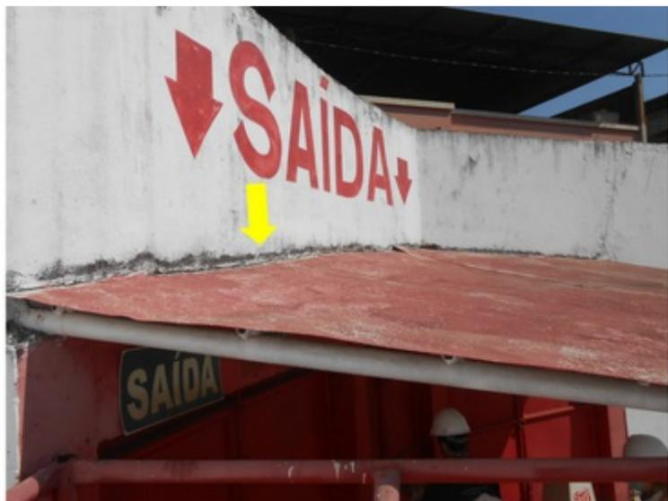
**F056** - SETORES 1 e 2 / ARQUIBANCADA - Ausência de sistema de drenagem adequado no passeio externo e água escoada no pé do muro do estádio.
