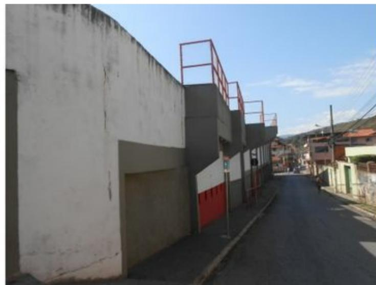
**F059** - SETORES 1 e 2 / ARQUIBANCADA - Ausência de sistema de drenagem adequado no passeio externo e água escoada no pé do muro do estádio.
