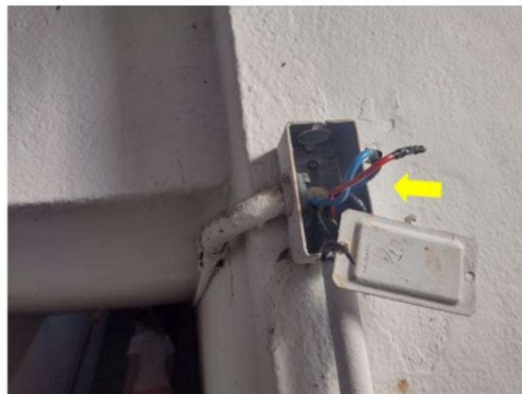
**F011** - SETOR 1 / SALA DA ARBITRAGEM - Caixa de passagem suja/ desorganizada/ sem tampa e próxima a indícios de infiltração.
