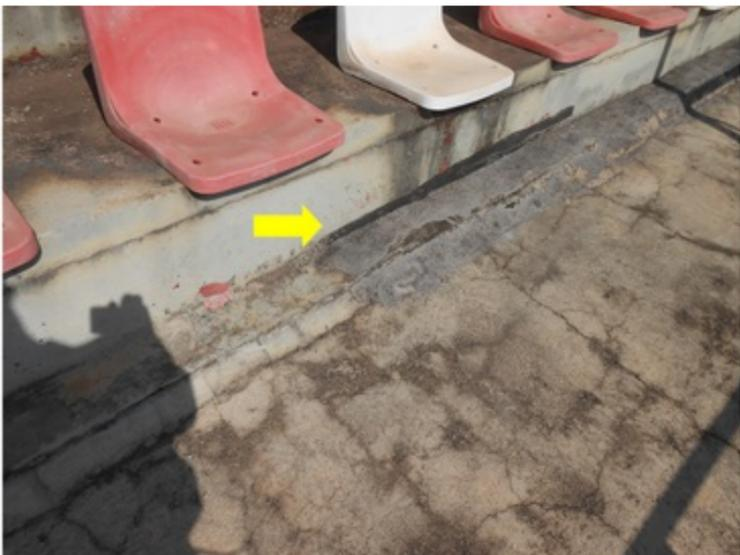
**F012** - SETORES 1,2 e 3 / ARQUIBANCADAS - Concreto deteriorado e manta exposta e soltando no piso da arquibancada.
