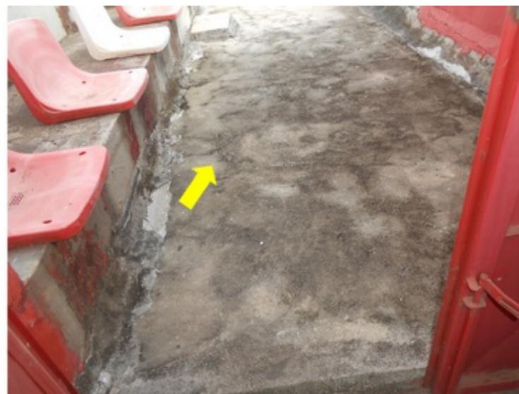
**F005** - SETORES 1,2 e 3 / ARQUIBANCADAS - Infiltração de água na laje das arquibancadas, através das perfurações na manta para fixação das cadeiras .
