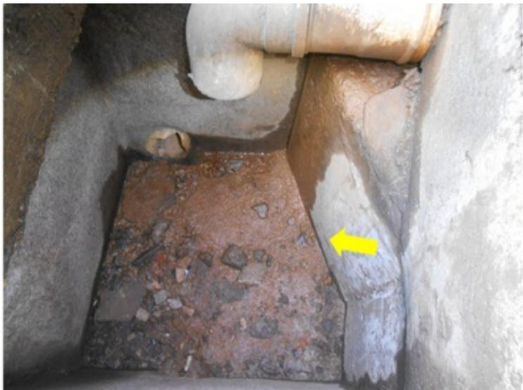
**F124** - SETOR 1 / PASSEIO EXTERNO - Vazamento na tubulação localizada dentro da caixa de passagem.
