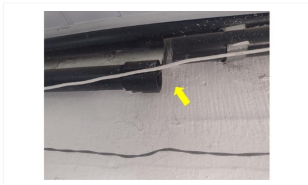
**F030** - SETOR 2/ IMPRENSA - Conexão inadequada do eletroduto.
