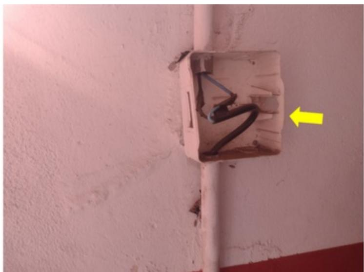
**F060** - SETOR 3 / TÚNEL DE ACESSO - Caixa de passagem sem identificação e com presença de vegetação.
