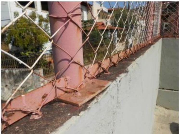
**F072** - SETOR 1 / ARQUIBANCADA - Infiltração no muro advinda das falhas na vedação da fixação do alambrado no mesmo.
