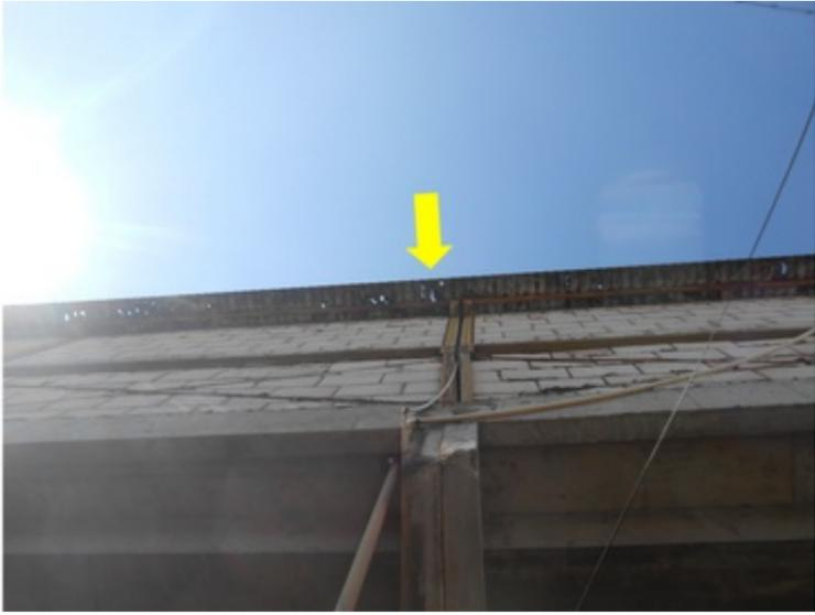
**F008** - SETOR 2 / ENTRADA SALA IMPRENSA - Telhado com pontos danificados e terça está oxidada.
