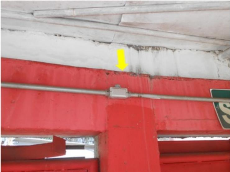
**F052** - SETORES 1 e 2 / ARQUIBANCADA - Infiltração na viga devido as falhas de vedação das chapas metálicas do telhado.
