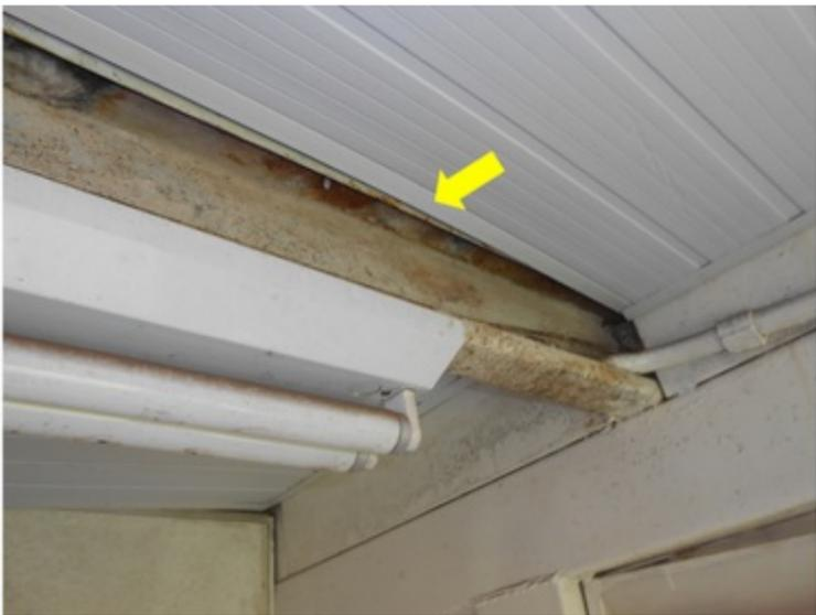
**F100** - SETOR 2 / SALA IMPRENSA - Infiltração no forro das cabines devido as falhas existentes no telhado.
