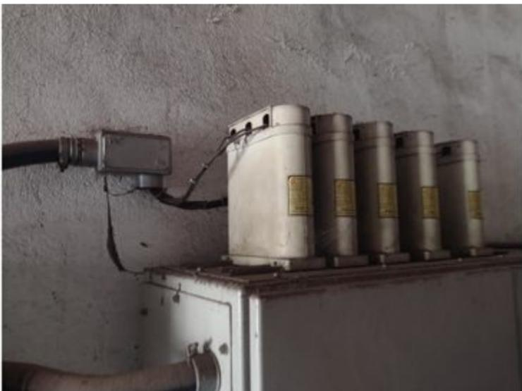
**F072** - SUBESTAÇÃO DE ENERGIA - Quadro de carga sujo/ sem identificação.
