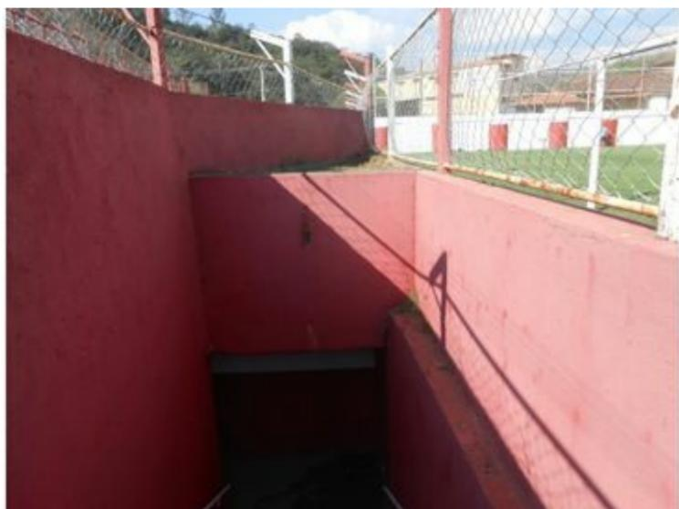
**F180** - SETOR 3 / TÚNEL DE ACESSO AO CAMPO - Infiltração na laje devido ao jardim localizado na área superior.
