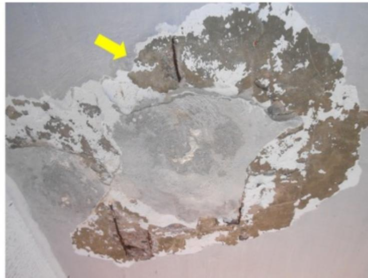
**F023** - SETOR 1 / SALA GERÊNCIA - Armação exposta na laje devido a infiltração ocasionada por vazamento na tubulação.
