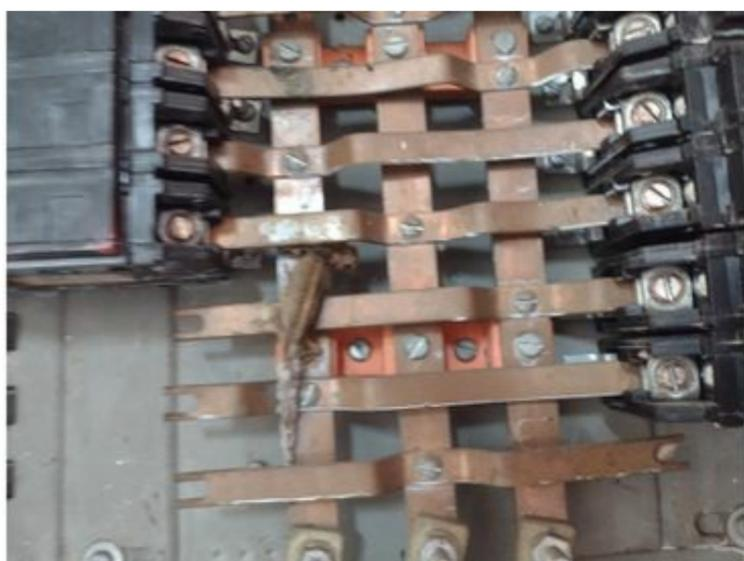
**F004** - SETOR 1 / BAR - Quadro de distribuição sem identificação/ circuitos sem identificação/ sem proteção contra toque direto e sem barramento PE.
