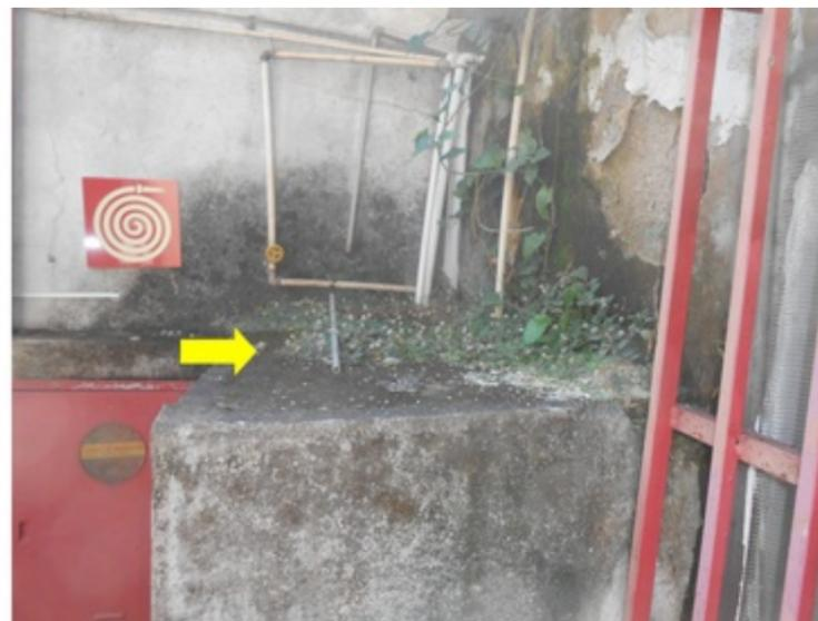
**F159** - SETOR 2 / ENTRADA SALA IMPRENSA - Infiltração advinda das falhas na impermeabilização da arquibancada.
