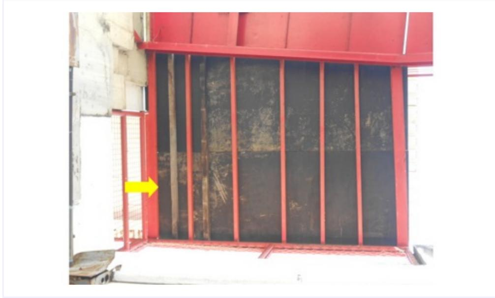
**F032** - SETOR 2 / ARQUIBANCADA - Estrutura do piso em madeira e metálica, não garantindo a segurança e estabilidade do local.
