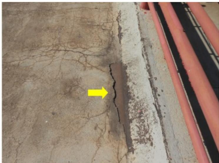
**F026** - SETORES 1,2 e 3 / ARQUIBANCADAS - Concreto deteriorado e manta exposta e soltando no piso da arquibancada.
