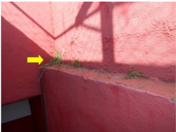
**F182** - SETOR 3 / TÚNEL DE ACESSO AO CAMPO - Presença de vegetação na alvenaria da escada de acesso ao campo.
