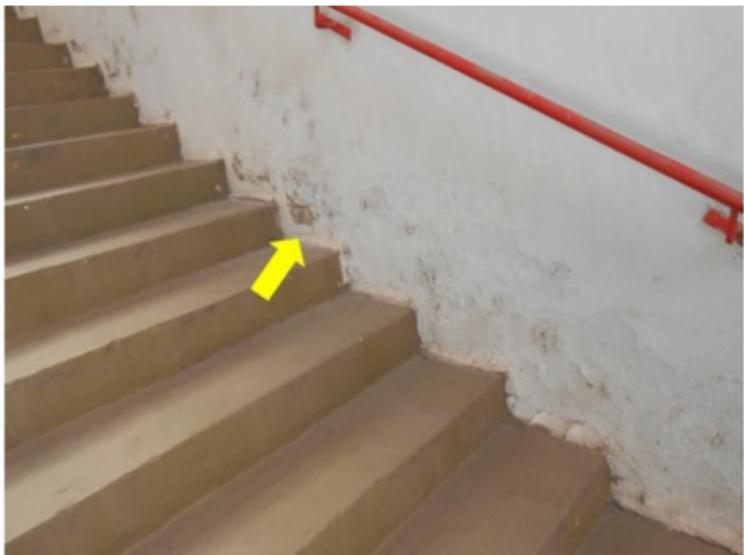
**F126** - SETOR 2 / COZINHA - Infiltração na alvenaria devido a falhas existentes na fachada.
