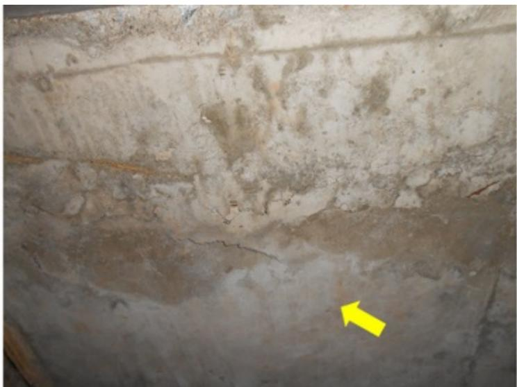
**F014** - SETOR 1 / BANHEIRO MASCULINO, FEMININO E BAR - Eflorescência, concreto escamando e armação exposta devido as falhas na impermeabilização da arquibanca...
