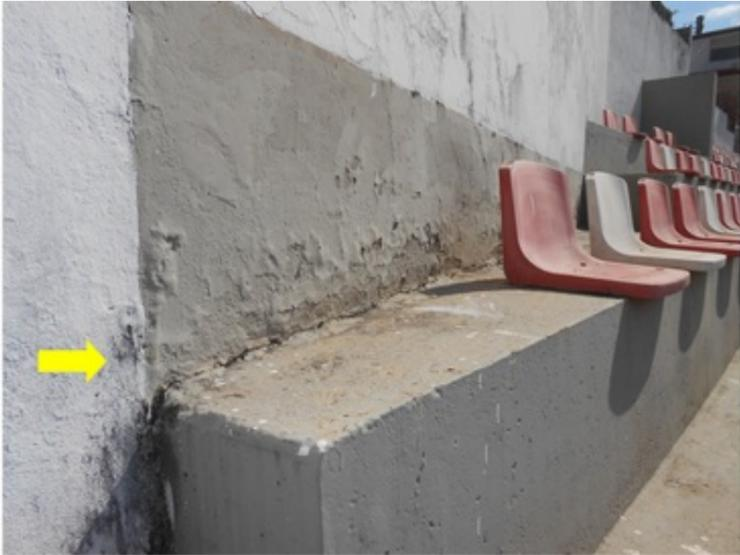
**F050** - SETORES 1 e 2 / ARQUIBANCADA - Infiltração na viga devido as falhas de vedação das chapas metálicas do telhado.
