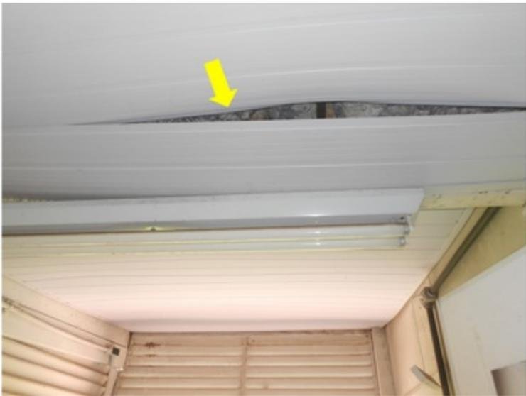
**F098** - SETOR 2 / SALA IMPRENSA - Infiltração no forro das cabines devido as falhas existentes no telhado.
