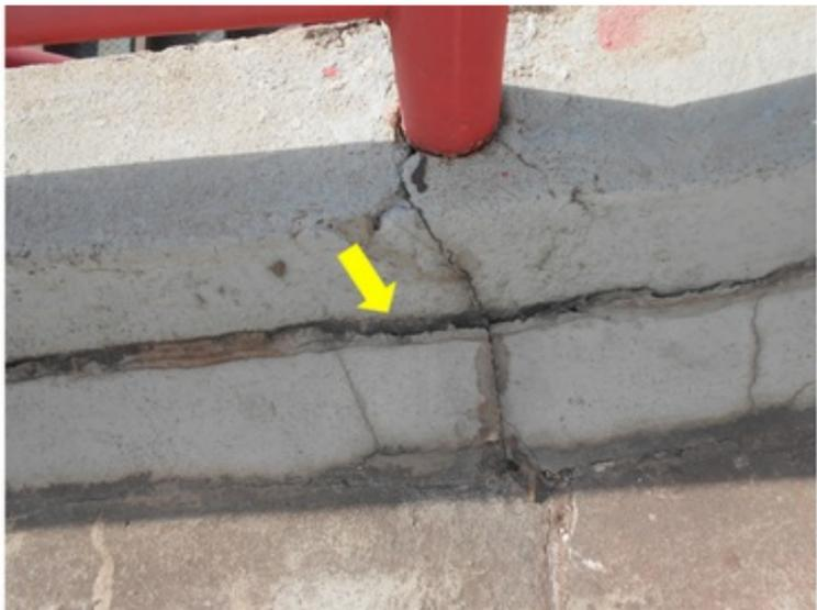
**F040** - SETORES 1,2 e 3/ ARQUIBANCADAS - Pontos danificados entre o alambrado e o piso, permitindo a infiltração de água no local.
