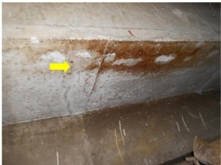
**F160** - SETOR 2 / ALOJAMENTOS - Infiltração e fissuras nas alvenarias devido as falhas encontradas no telhado e piso do corredor localizado para a entrada na ...
