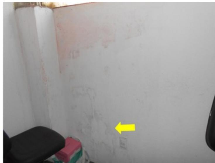
**F117** - SETOR 1 / SALA GERÊNCIA - Infiltração na alvenaria confrontante com a arquibancada, advinda das falhas da impermeabilização da arquibancada.
