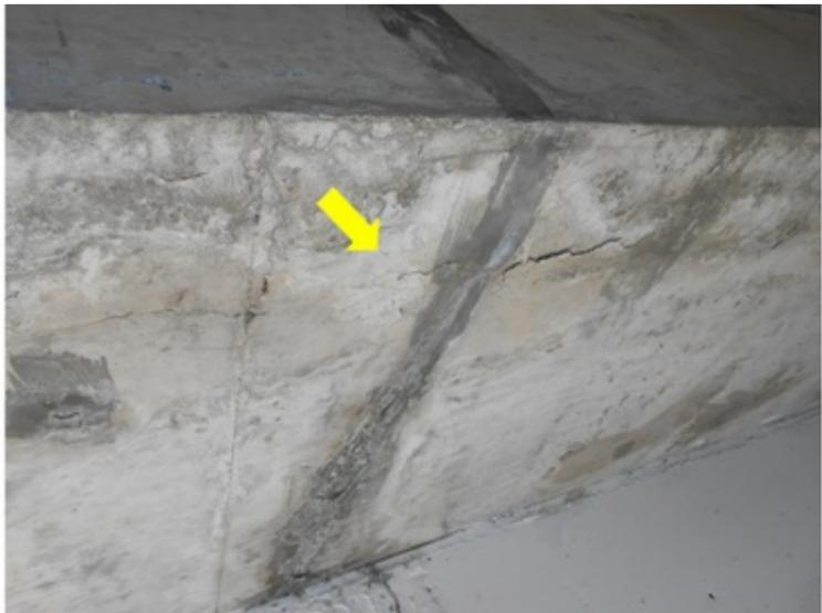
**F068** - SETOR 1 / BAR - Indícios de infiltração advinda das falhas na impermeabilização da arquibancada.
