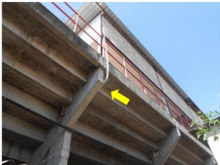
**F014** - SETOR 2 / ENTRADA SALA IMPRENSA - Tubulação do ladrão das caixas d'água estão direcionadas para o telhado, ocasionando infiltração.
