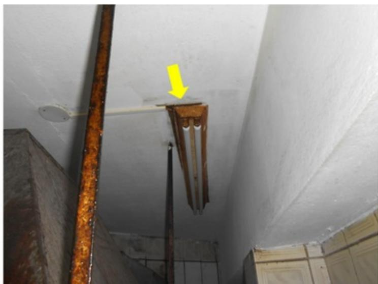
**F138** - SETOR 2 / COZINHA - Infiltração, armação exposta, revestimentos com som cavo, devido ao telhado danificado e tubulação do ladrão de água direcionado p...
