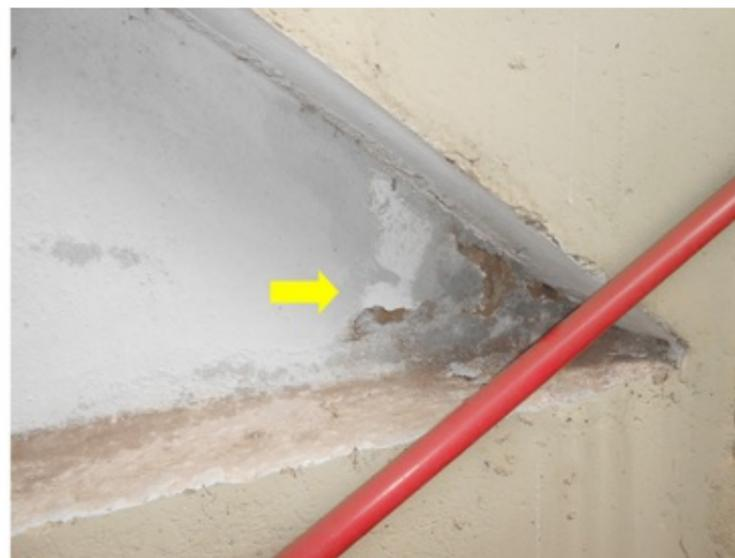
**F119** - SETOR 1 / SALA GERÊNCIA - Infiltração na alvenaria confrontante com a arquibancada, advinda das falhas da impermeabilização da arquibancada.
