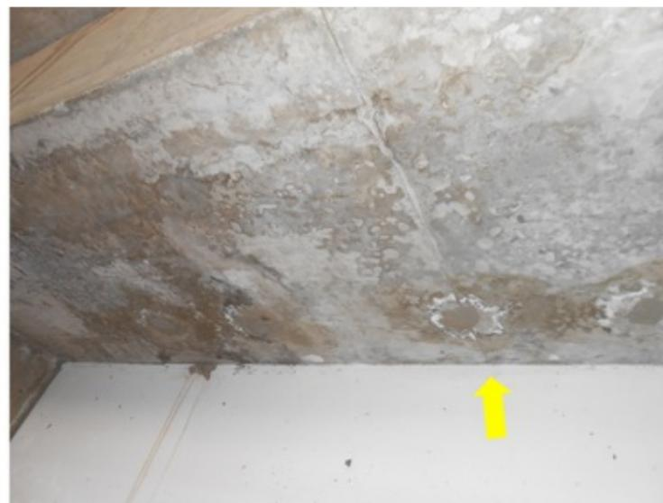
**F017** - SETOR 1 / BANHEIRO MASCULINO, FEMININO E BAR - Eflorescência, concreto escamando e armação exposta devido as falhas na impermeabilização da arquibanca...
