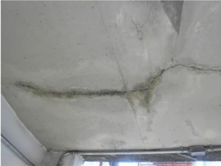
**F152** - SETOR 2 / ENTRADA SALA IMPRENSA - Empoçamento de água na laje superior ocasionando infiltração.
