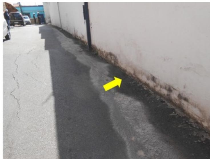
**F057** - SETORES 1 e 2 / ARQUIBANCADA - Ausência de sistema de drenagem adequado no passeio externo e água escoada no pé do muro do estádio.
