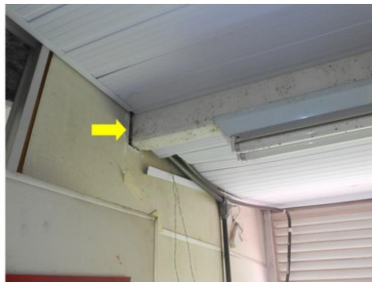
**F003** - SETOR 2 / SALA IMPRENSA - Terça do telhado está oxidada nas cabines 6, 9 e 10.
