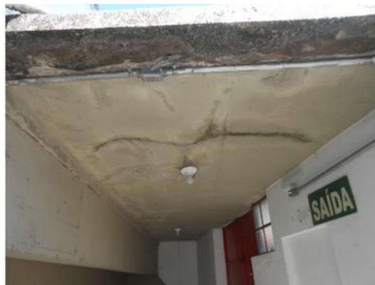
**F149** - SETOR 2 / ENTRADA SALA IMPRENSA - Empoçamento de água na laje superior ocasionando infiltração.
