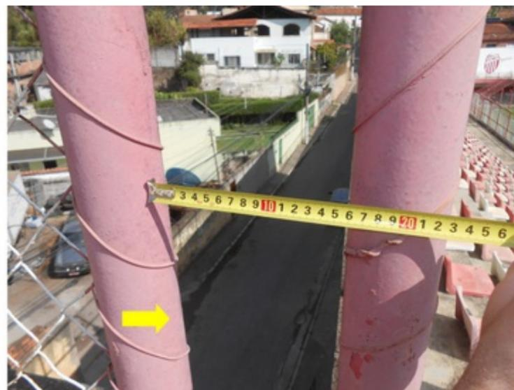
**F005** - SETOR 2 / ARQUIBANCADA - Ausência de continuidade na estrutura do alambrado.
