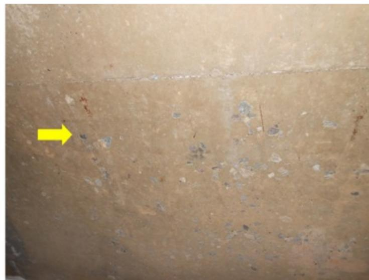
**F167** - SETOR 2 / SANITÁRIO FEMININO - Infiltração na laje devido as falhas na impermeabilização da arquibancada.
