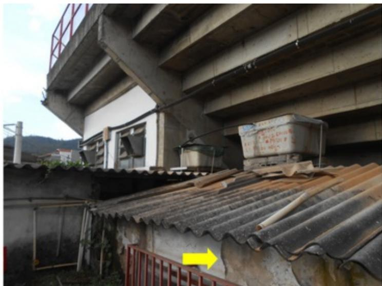
**F134** - SETOR 2 / COZINHA - Infiltração, armação exposta, revestimentos com som cavo, devido ao telhado danificado e tubulação do ladrão de água direcionado p...
