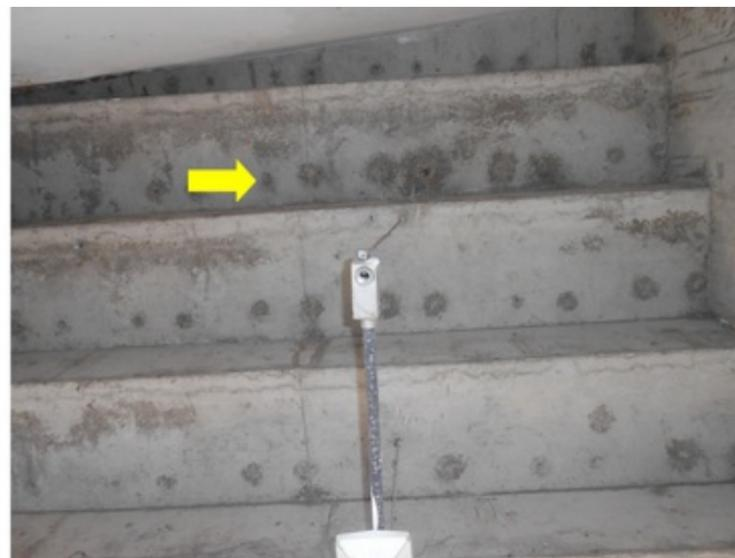
**F093** - SETOR 2 / SALA IMPRENSA - Infiltração no forro das cabines devido as falhas existentes no telhado.
