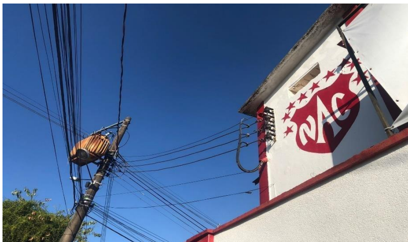
Figura 13 - Saída dos cabos
