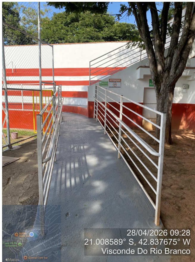
Figura 24 - Rampa de Acesso às Arquibancadas
