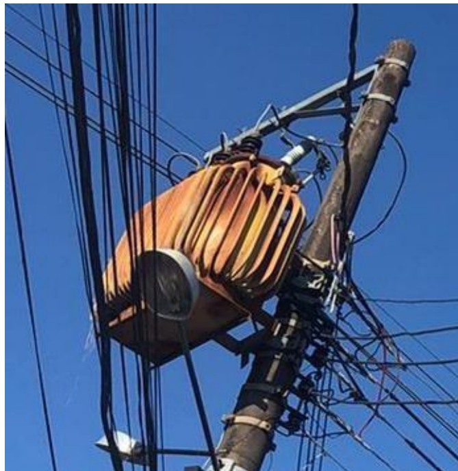
Figura 12 – Para raios de distribuição
