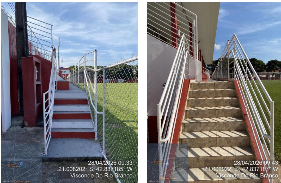
Figura 25 - Escadas da Arquibancada
