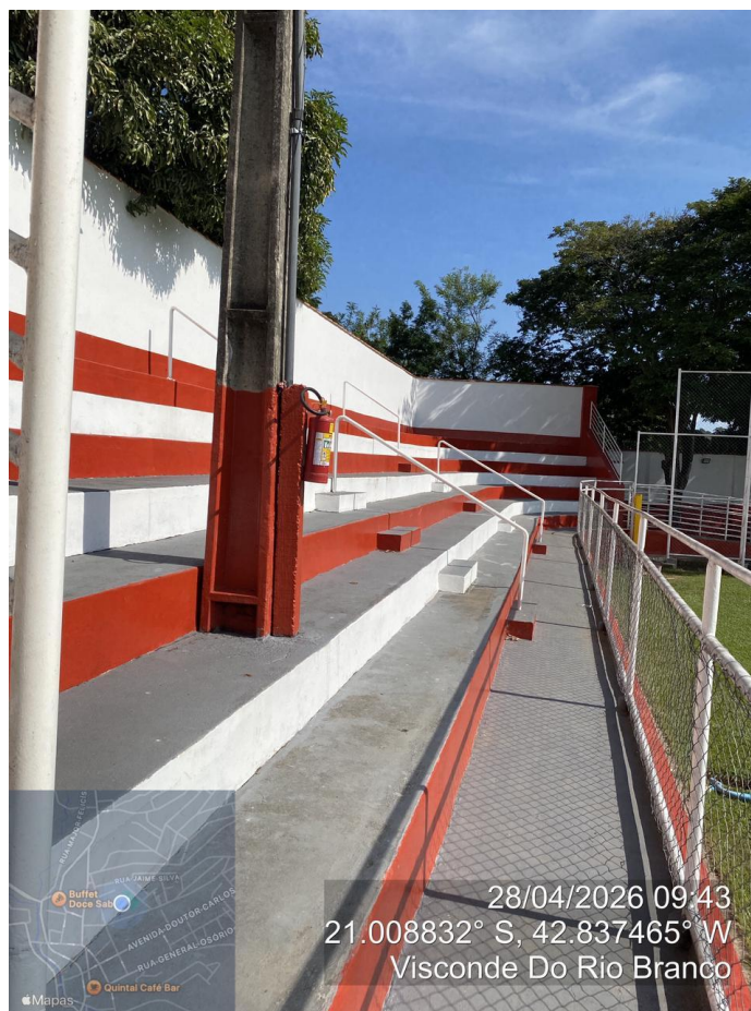
Figura 29 - Localização do guarda-corpo
