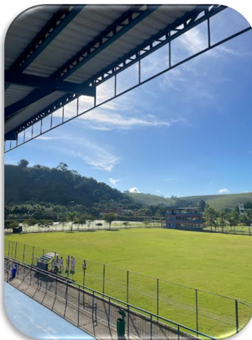
Fotografia 24: Vista da entorno do campo cercado com alambrados
