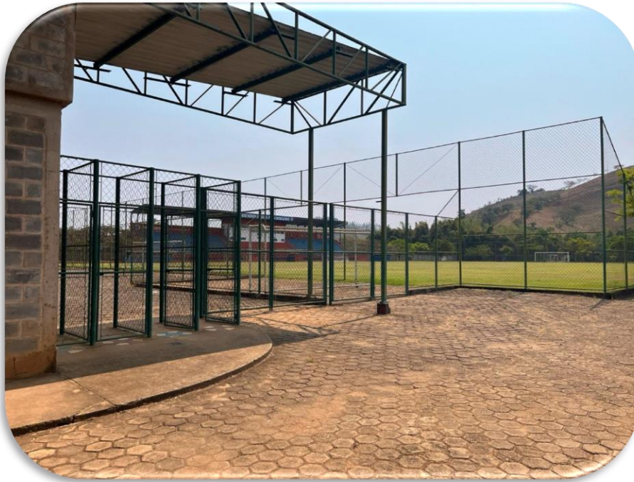
Fotografia 25: Vista de trecho de campo próximo ao portão de entrada
