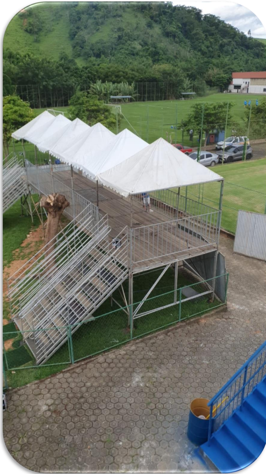
Fotografia 23: Vista da área reservada às delegações
