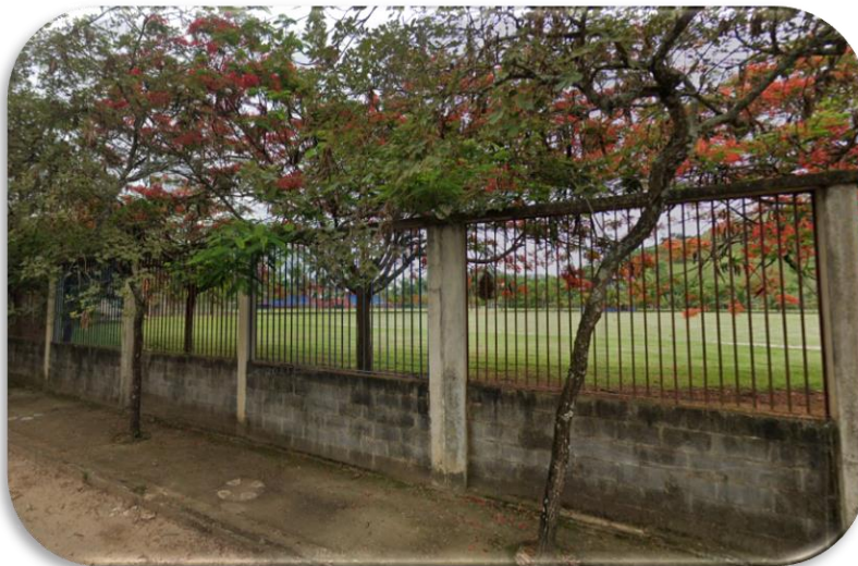
Fotografia 20: Trechos de proteção do Estádio através de grades.
