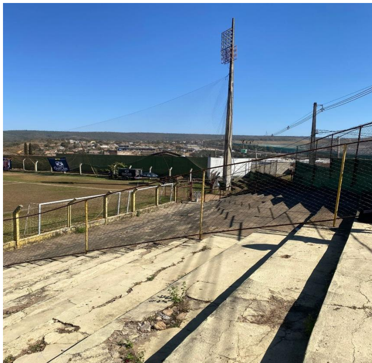
Figura 21 – Arquibancadas com parte da estrutura deteriorada
