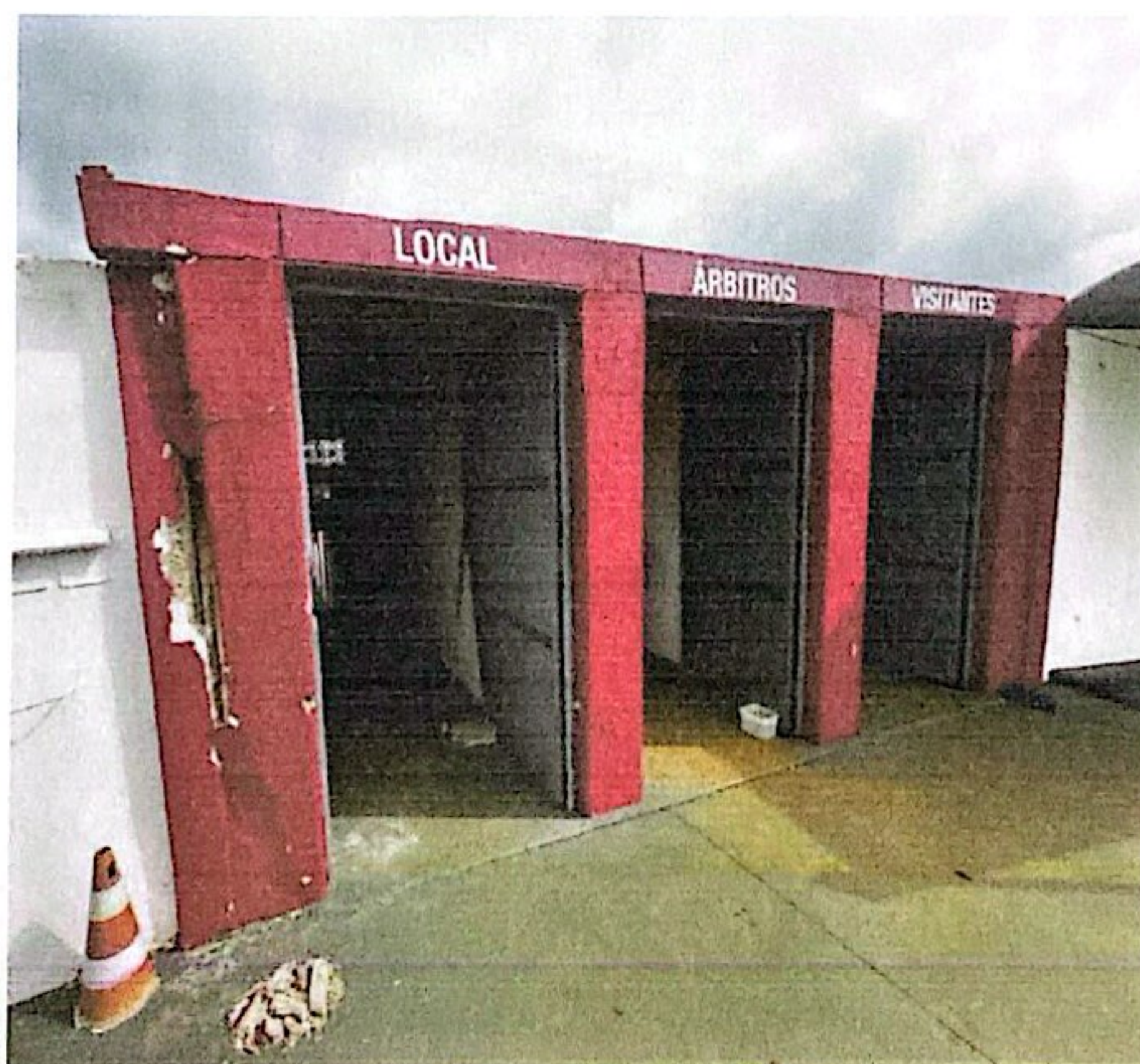
FOTO: Entrada do túnel de acesso aos vestiários.
