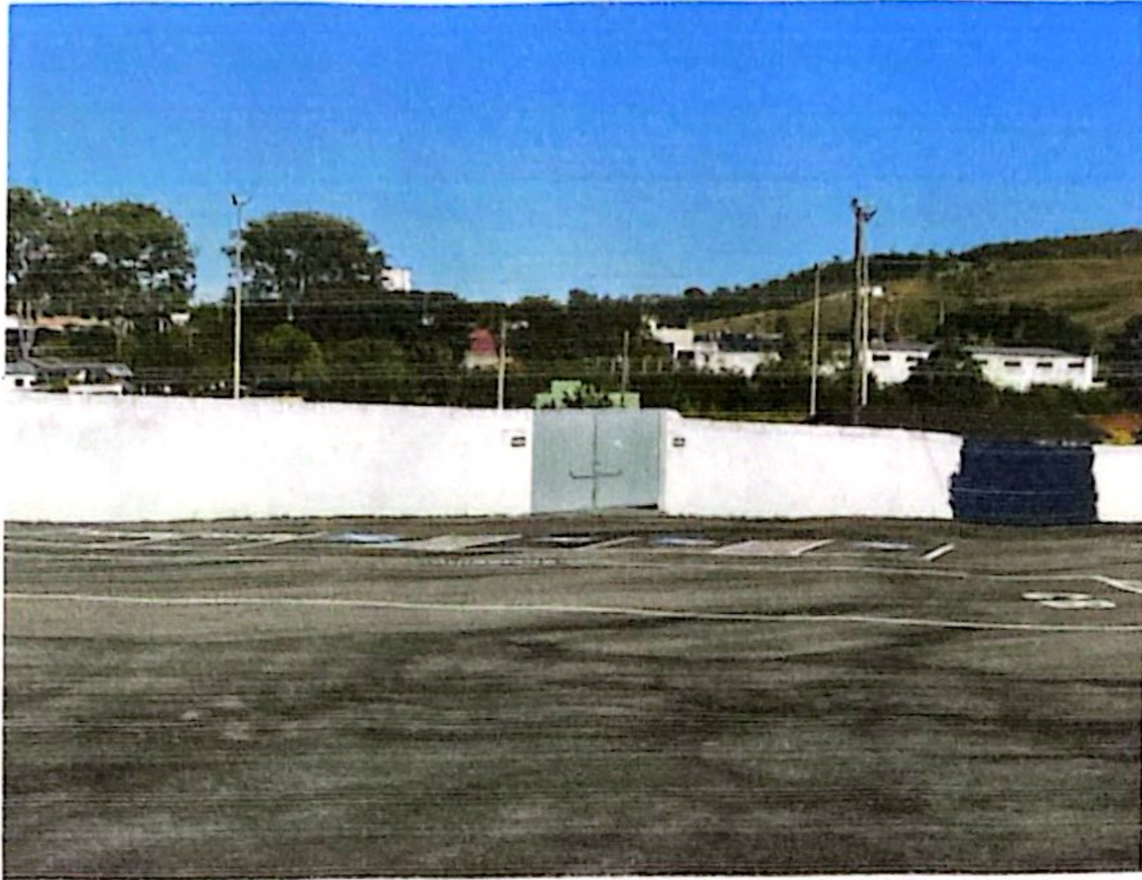
FOTO: Vista interna de saída de emergência estacionamento.
