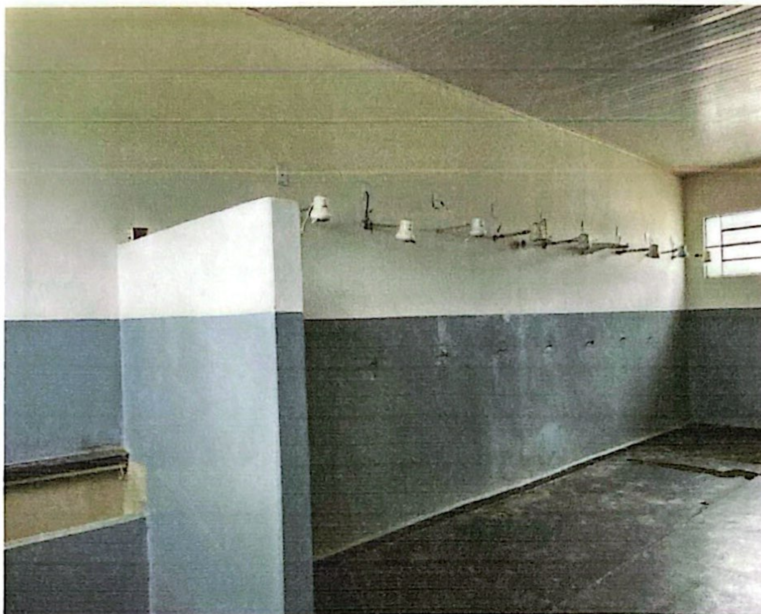
FOTO: Bloco de vestiários para agremiação visitante.
