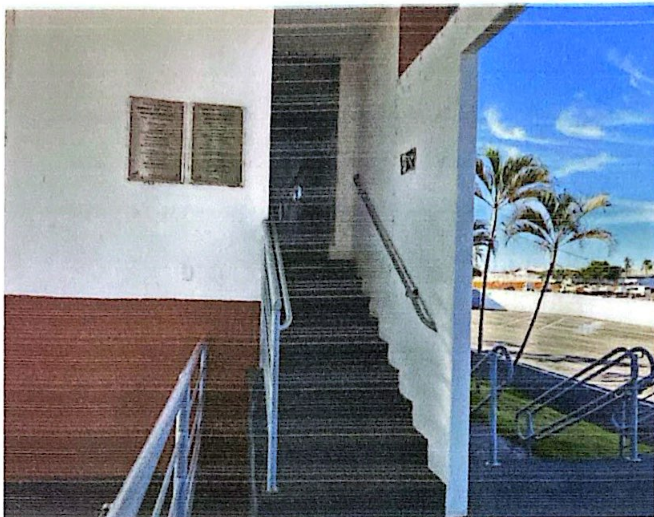
FOTO: Escada de acesso às cabines de imprensa.
