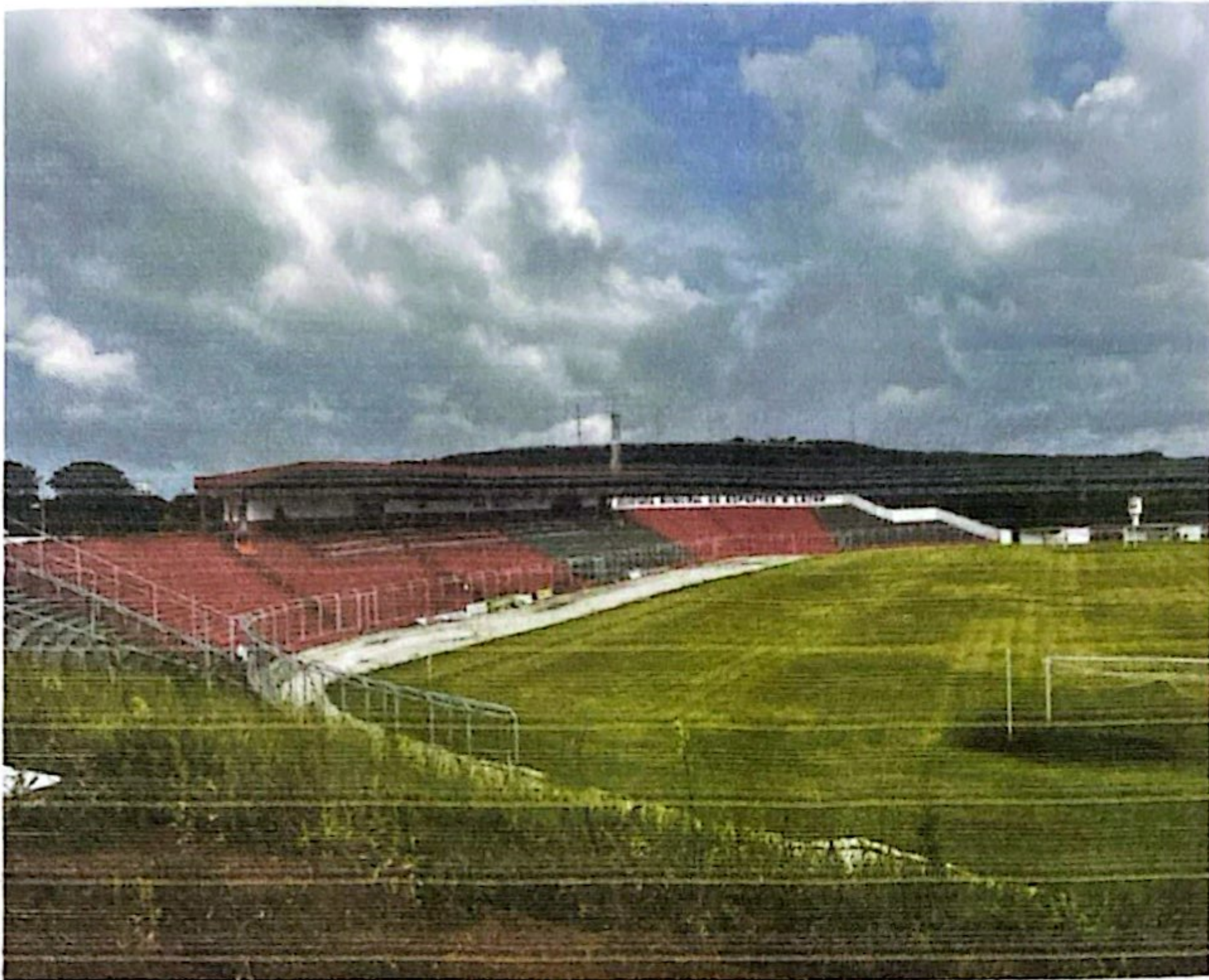
FOTO: Vista Geral arquibancadas e campo.
