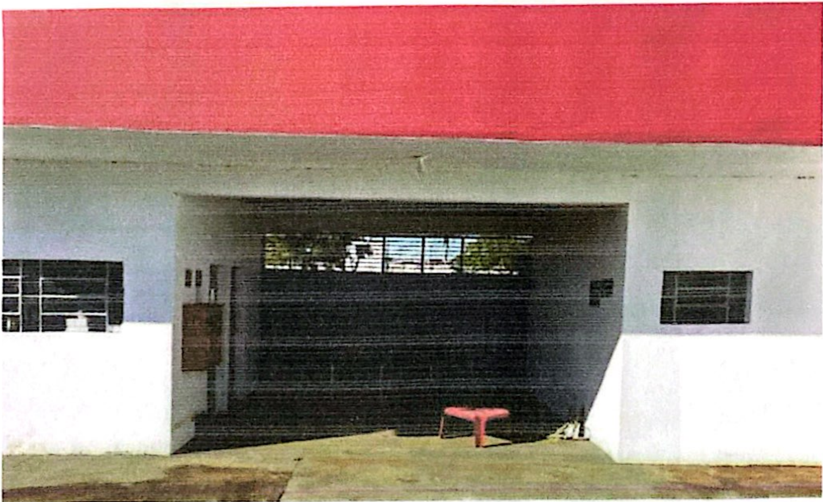
FOTO: Vista interna de acesso para torcedores da agremiação visitante.
