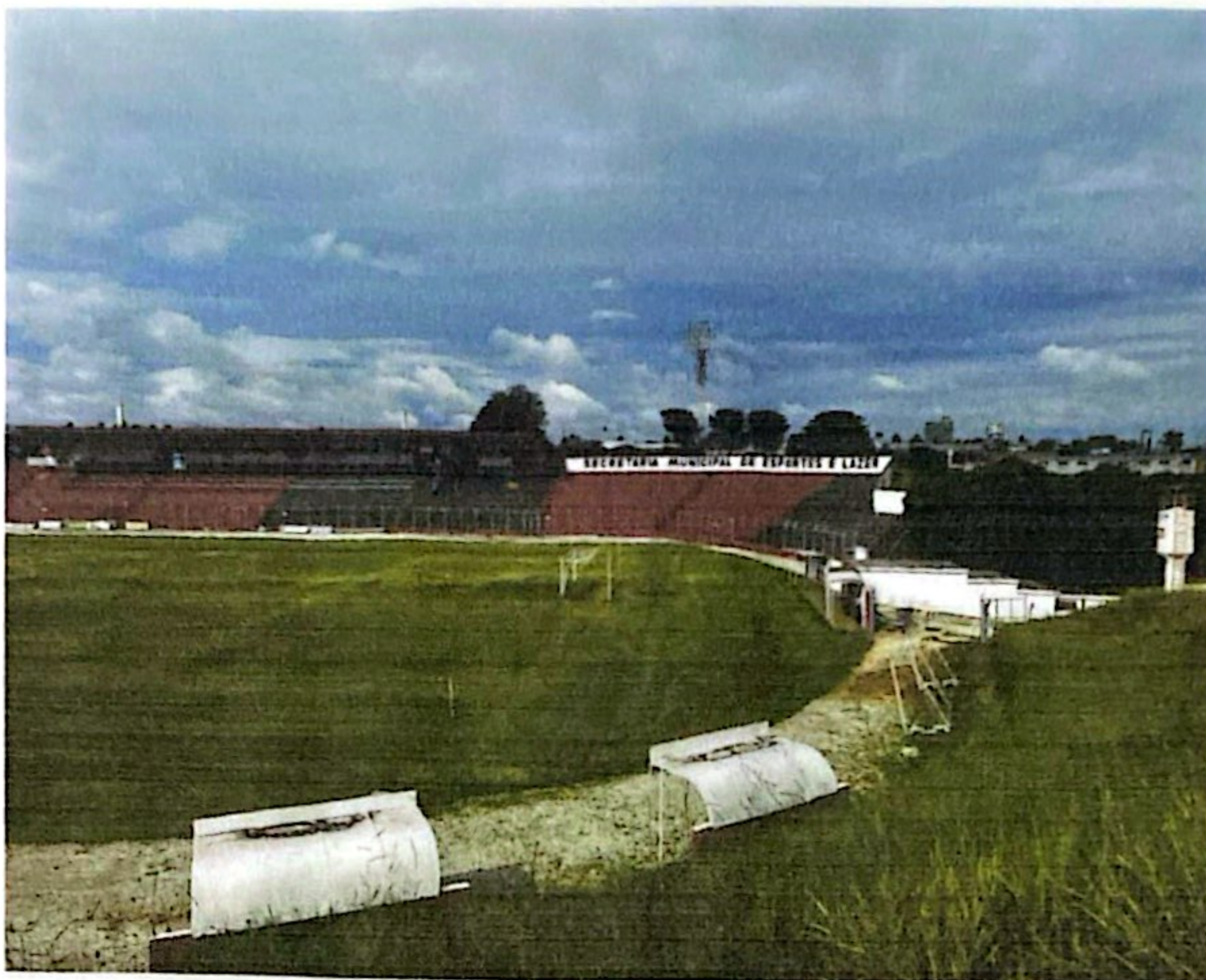
FOTO: Vista Geral arquibancadas, campo e bancos.
