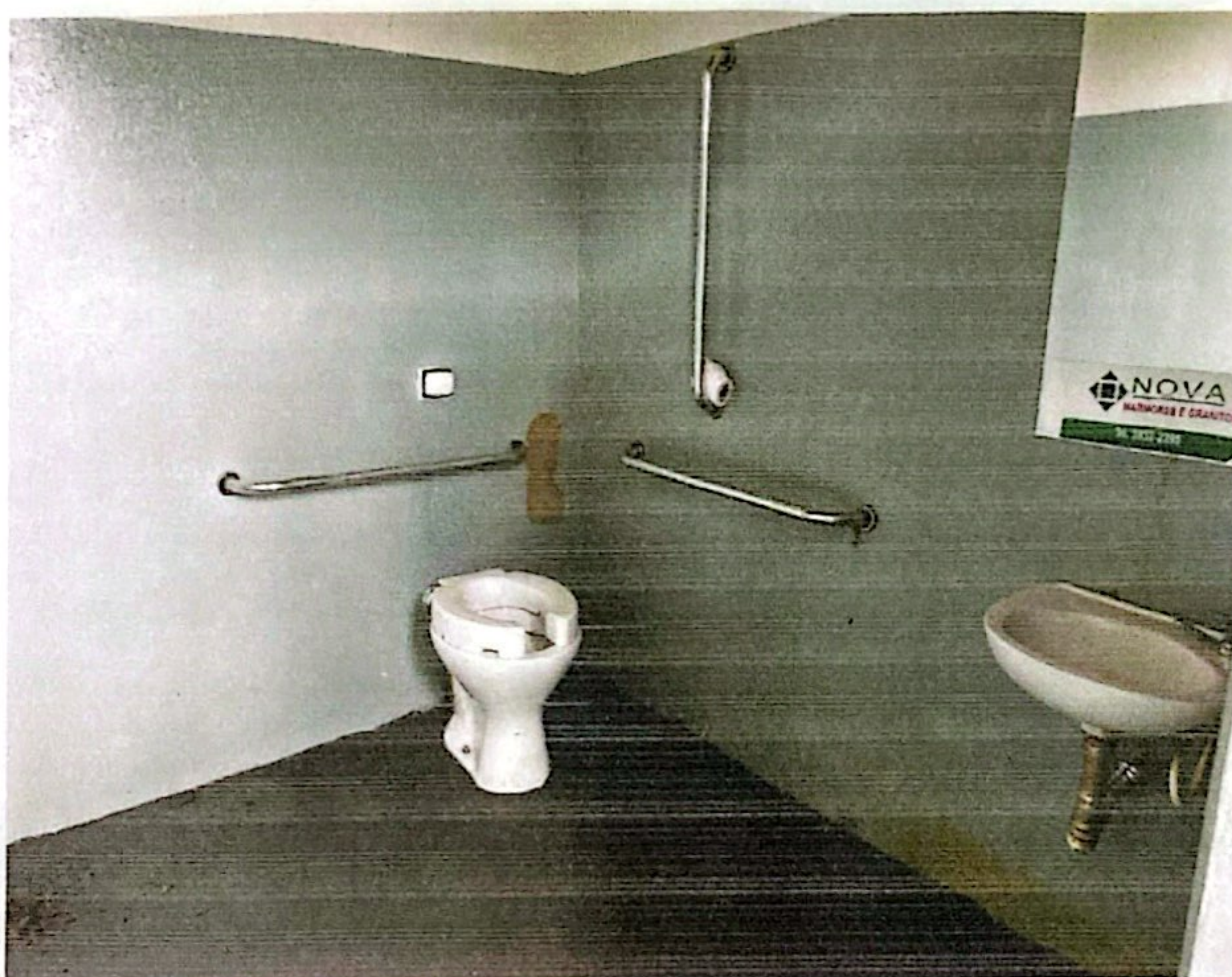
FOTO: Sanitários acessíveis dos torcedores da agremiação visitante.
