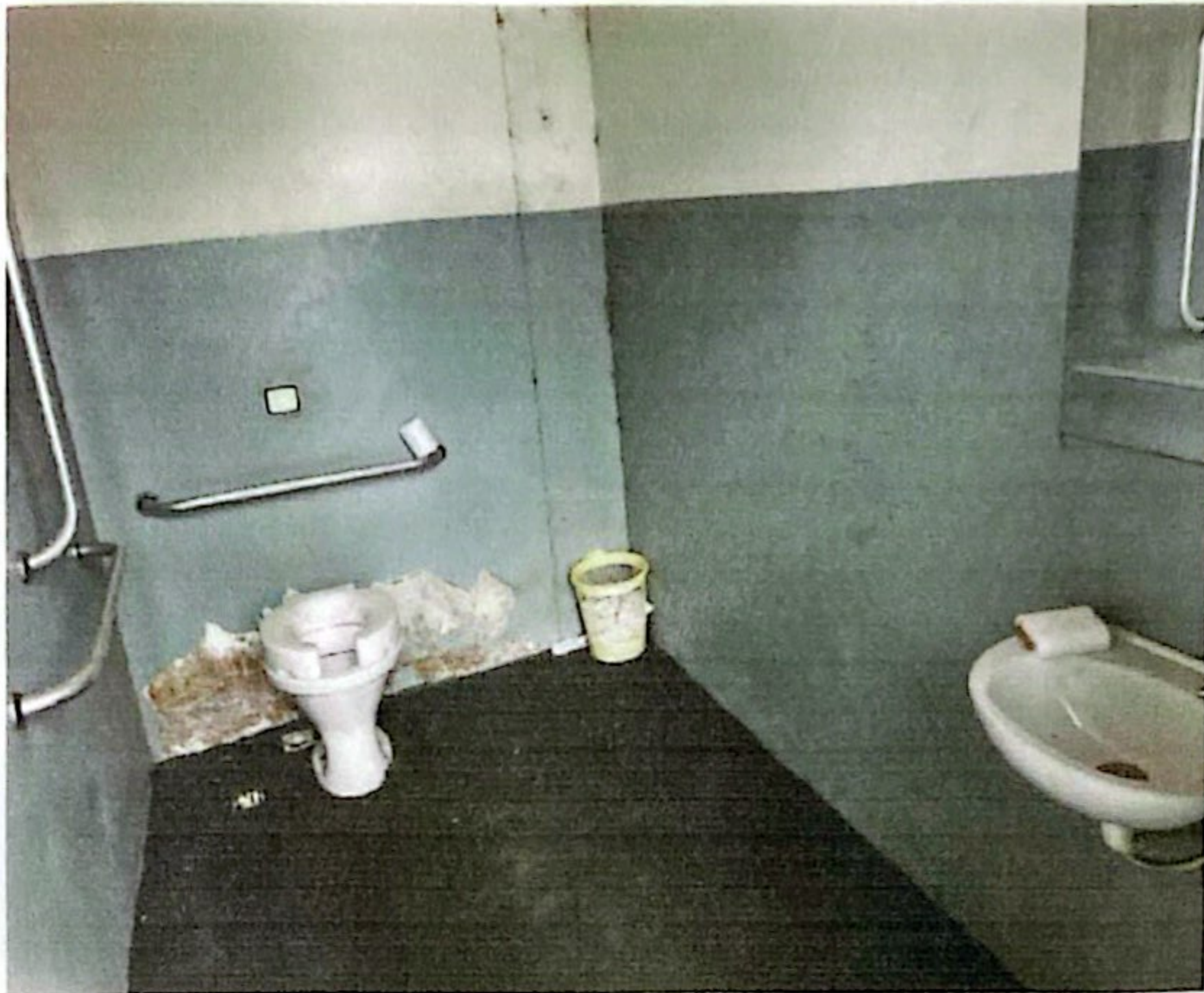
FOTO: Sanitário acessível masculino do setor de torcedores da agremiação local.
