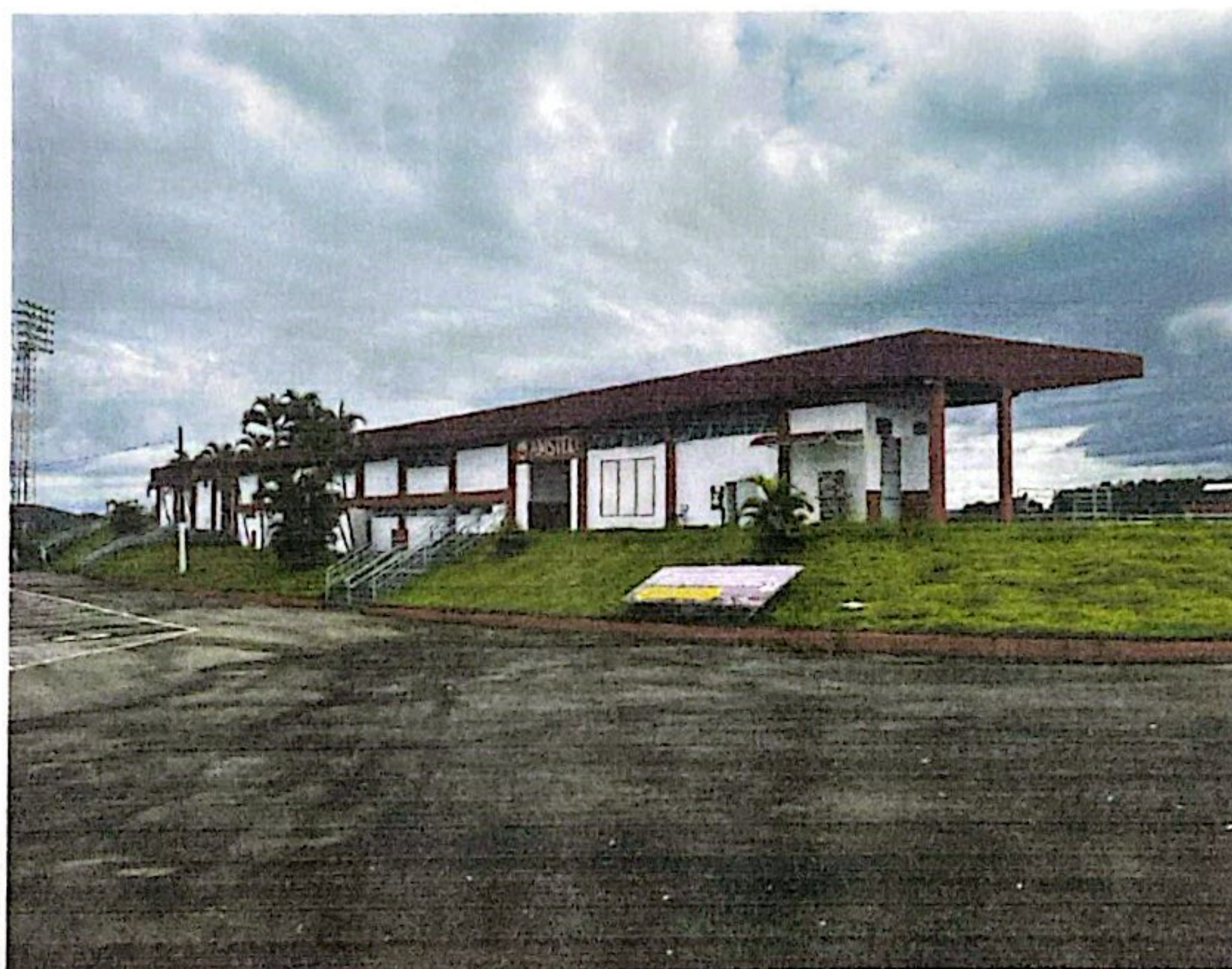
FOTO: Vista do Bloco de cabines de imprensa, sanitários, bar e posto médico para torcedores da agremiação local.
