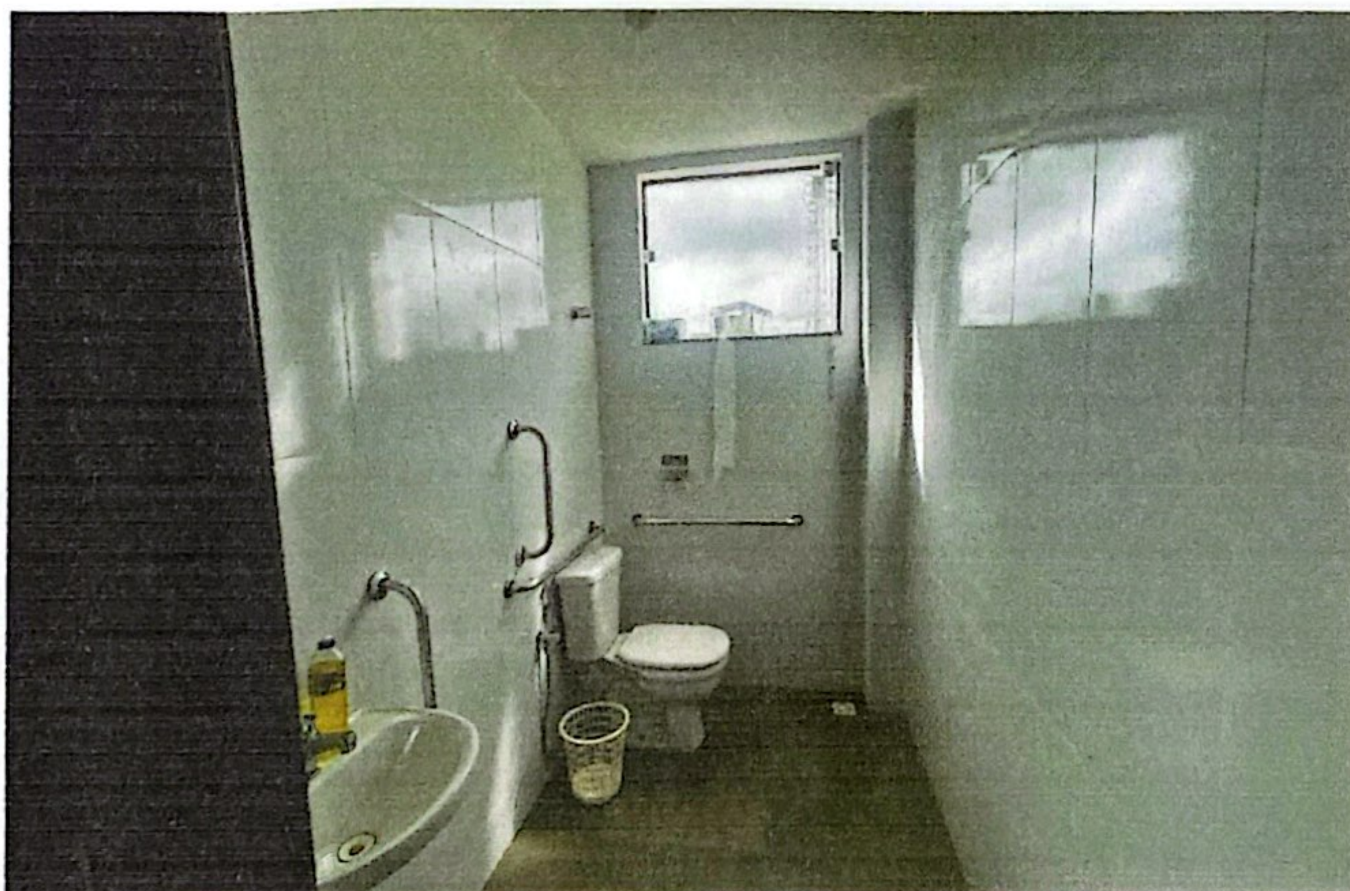
FOTO: Sanitário PCD masculino bloco do VAR.
