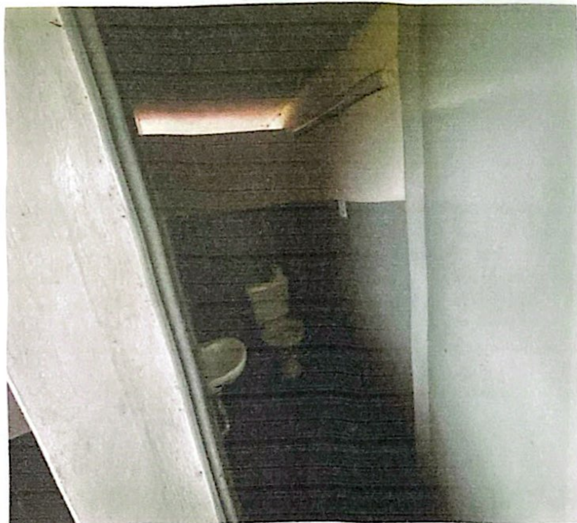
FOTO: Banheiros cabine de imprensa.
