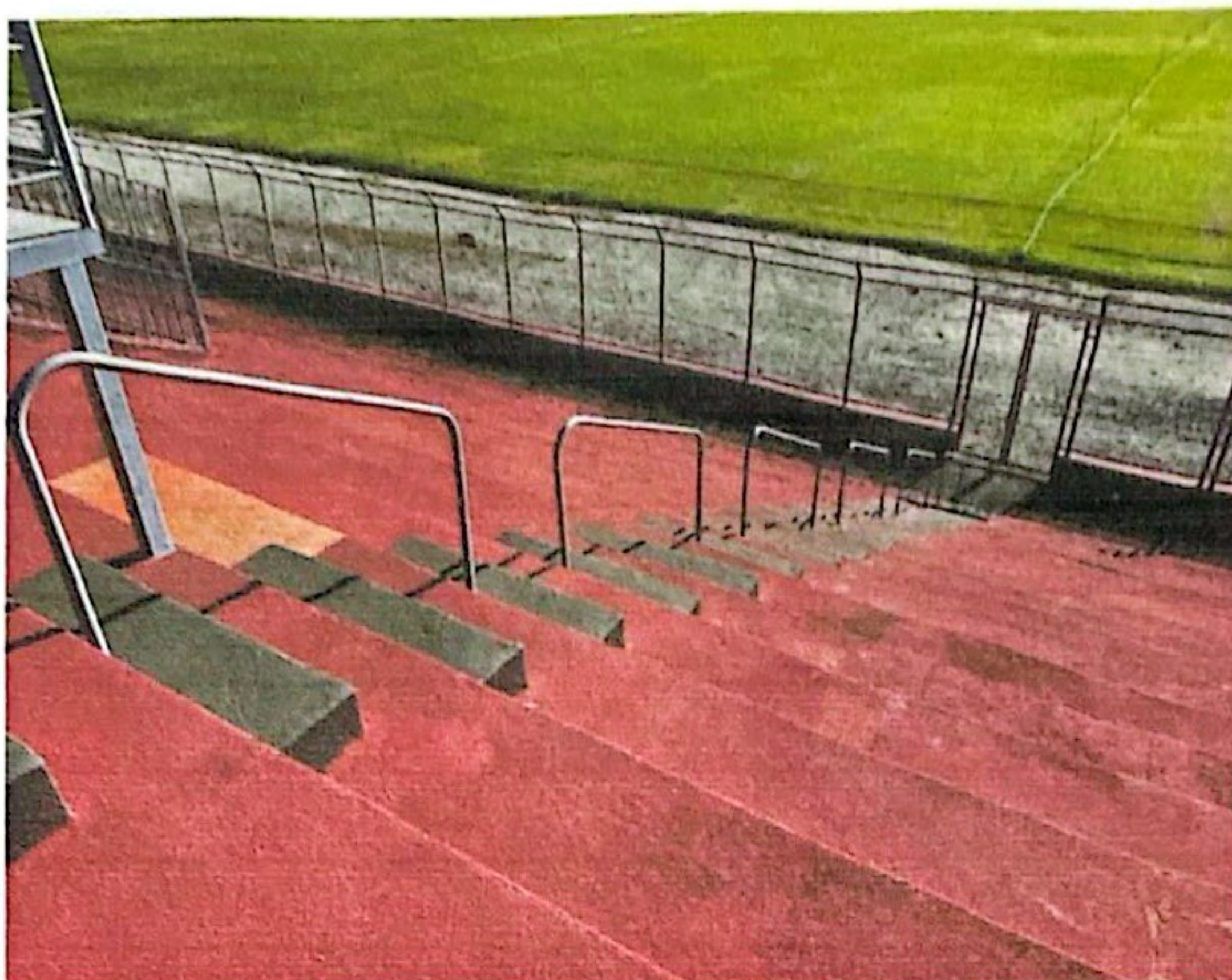
FOTO: Escada padrão das arquibancadas do setor de torcedores da agremiação local.
