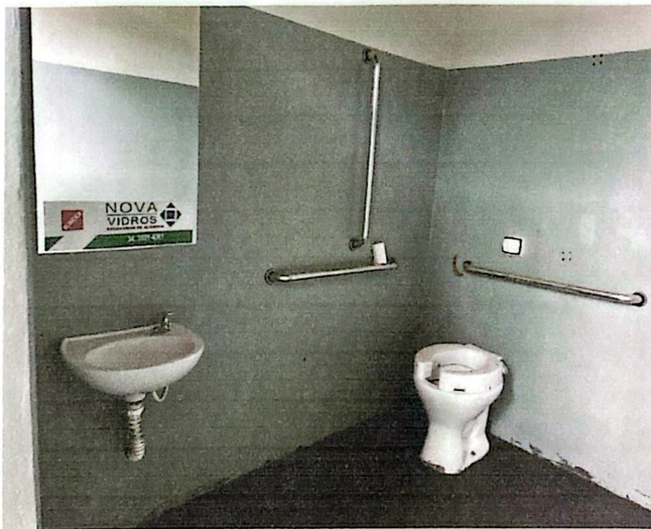
FOTO: Sanitário acessível feminino do setor de torcedores da agremiação local.
